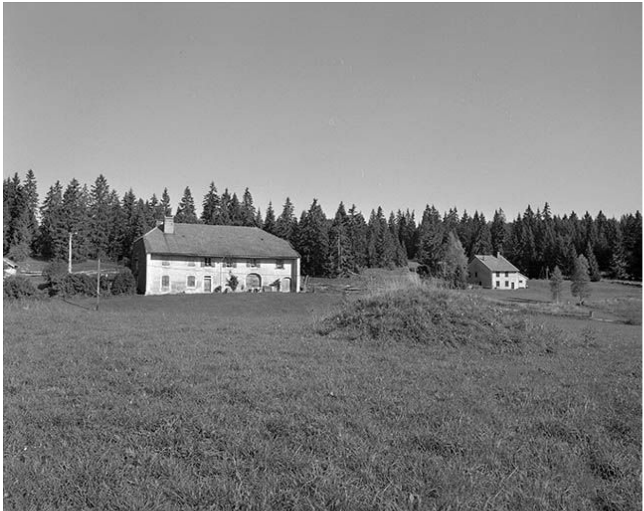
Façade antérieure, vue éloignée.
