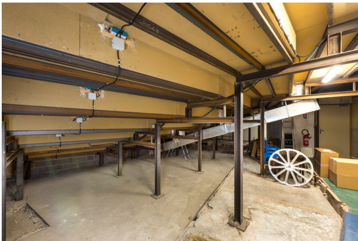
Espace sous les gradins de la salle.
