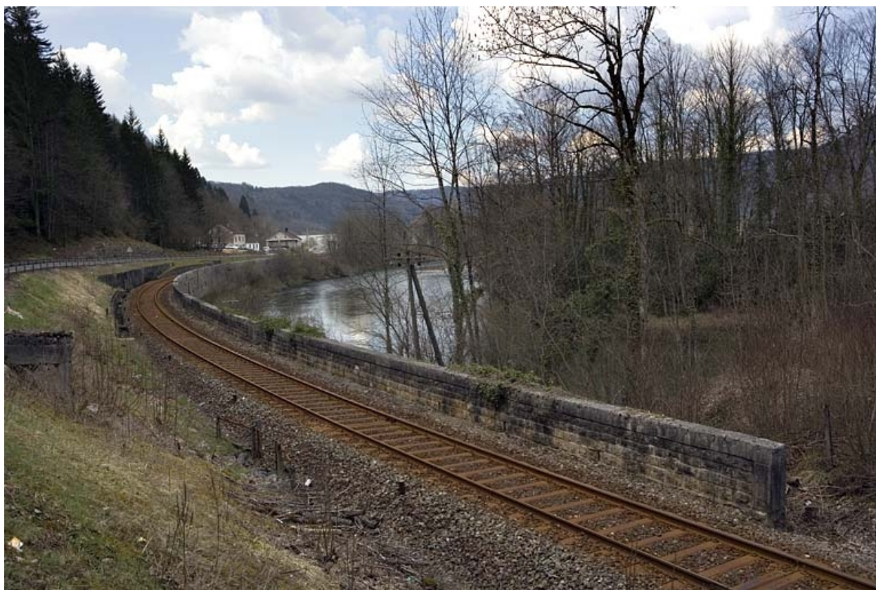
Vue d'ensemble, depuis le côté Andelot-en-Montagne.
