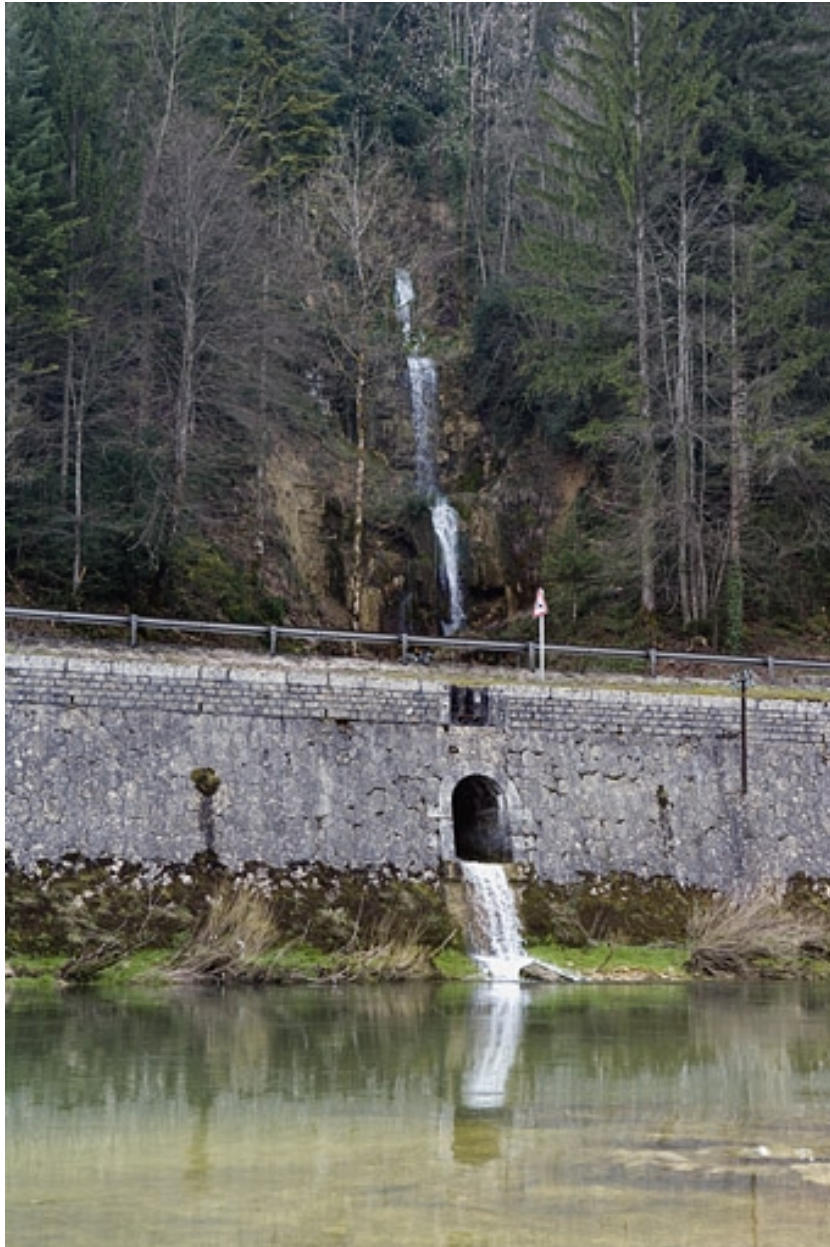
Aqueduc du ruisseau du Tournachut.
