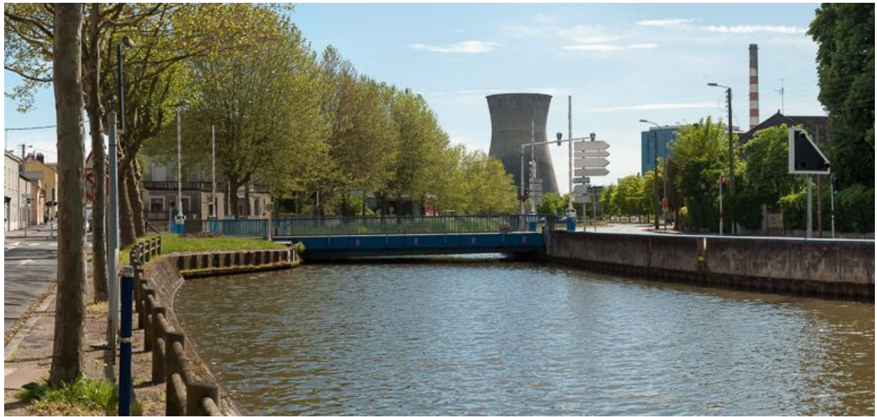
Vue d'ensemble du pont.
