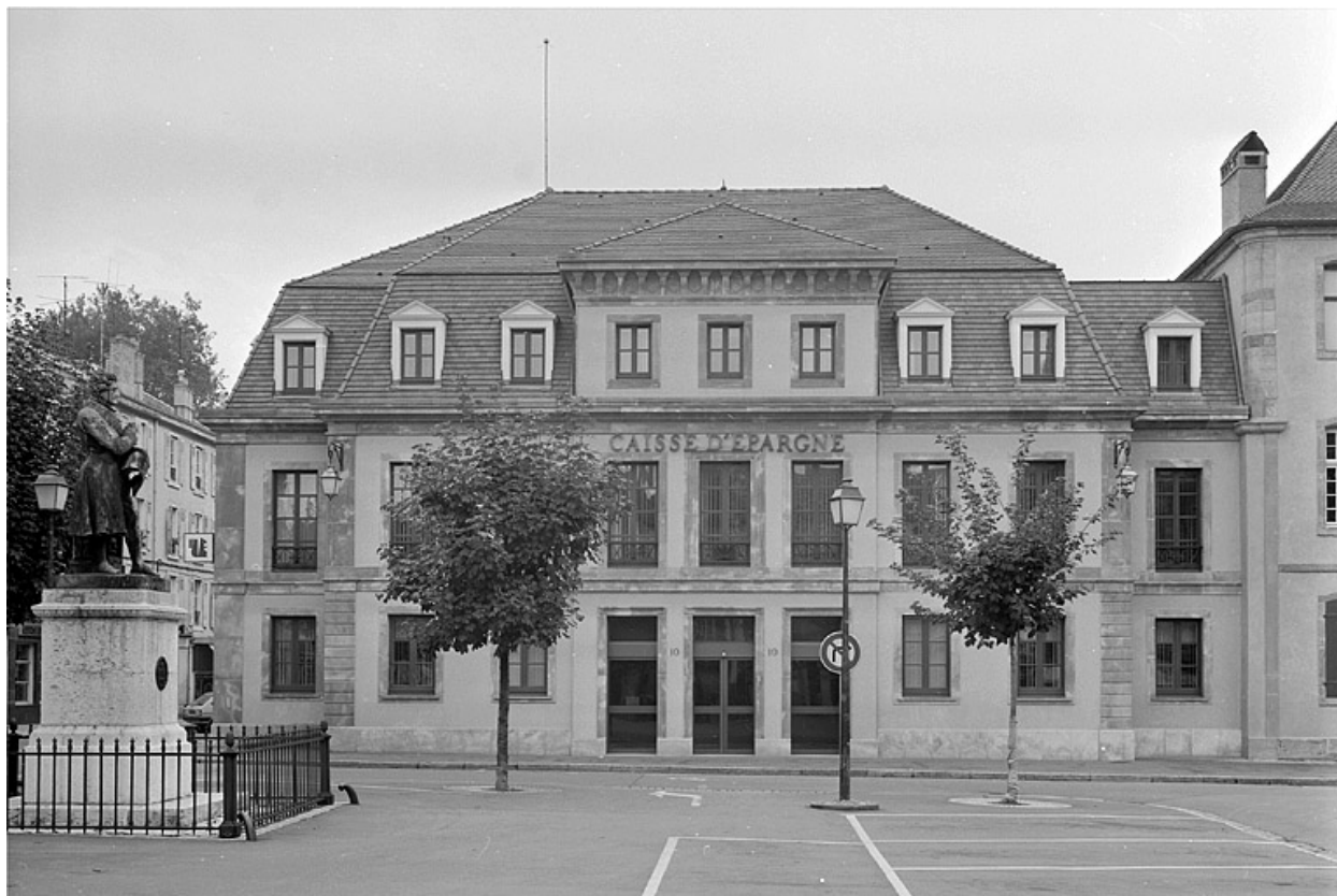
Façade nord après reconstruction.
