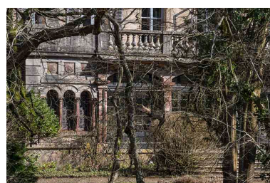
Vue du rez-de-chaussée, façade sud-ouest. Phot. Jérôme Mongreville IVR43_20187000113NUC4A
