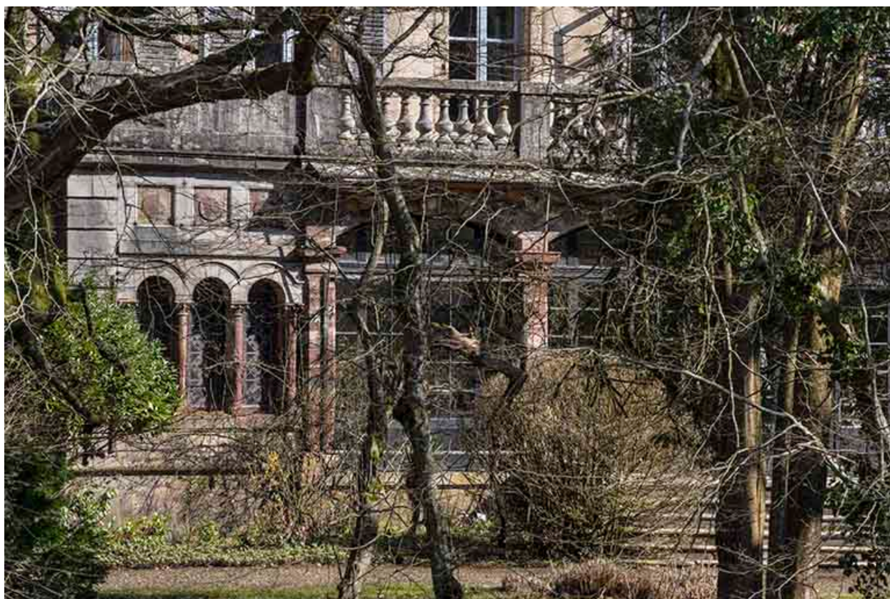
Vue du rez-de-chaussée, façade sud-ouest.
