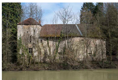
Les communs, vue de détail. Phot. Jérôme Mongreville IVR43_20187000121NUC4A
