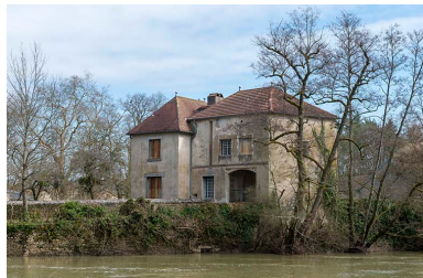
La porte septentrionale et l'ancien pont-levis. Phot. Jérôme Mongreville IVR43_20187000122NUC4A
