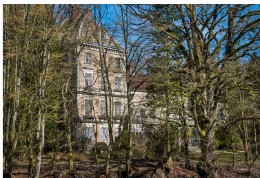
Le pavillon occidental, façade sud-ouest. Phot. Jérôme Mongreville IVR43_20187000117NUC4A
