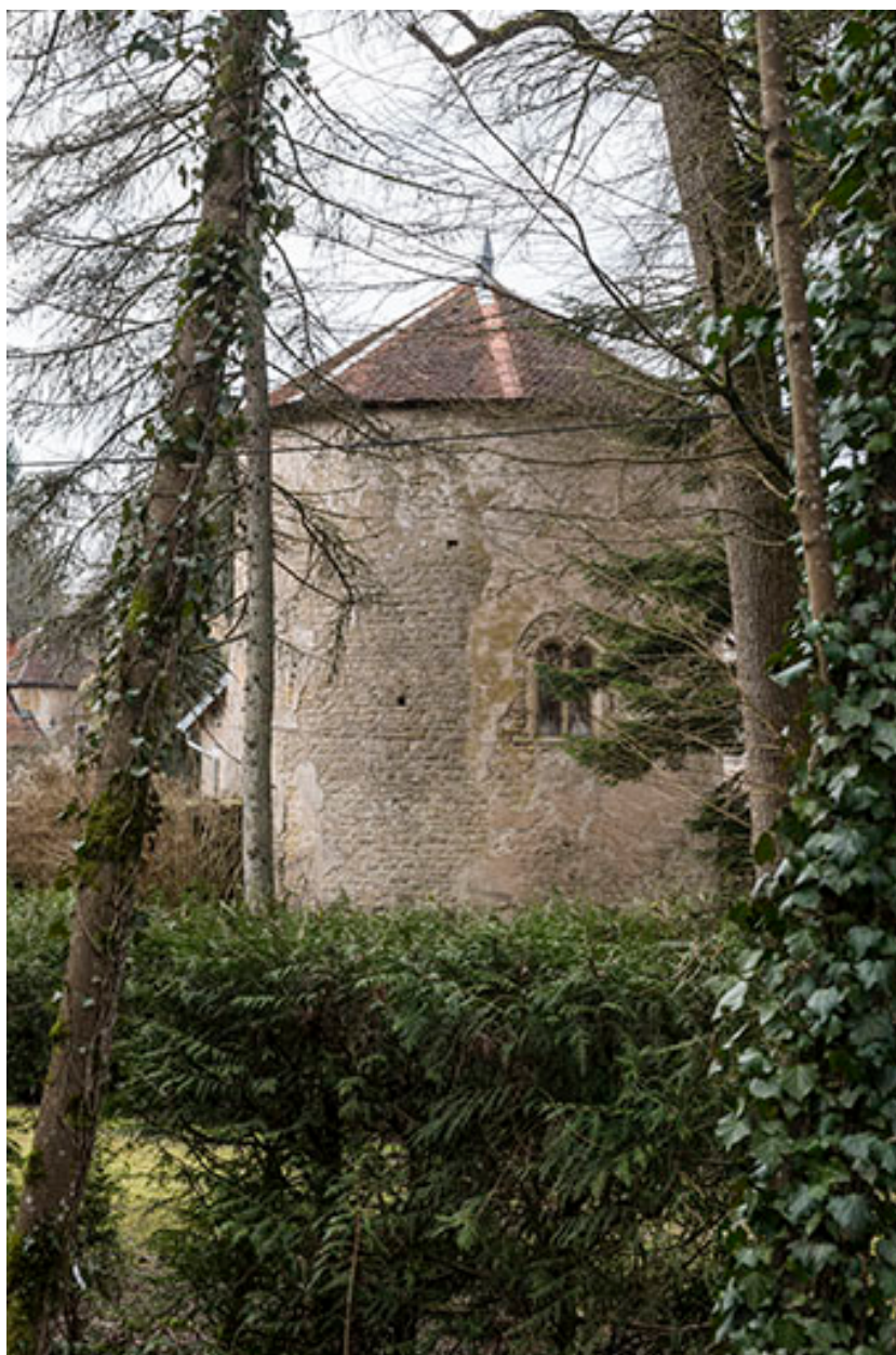
Tour située dans la cour du château.
