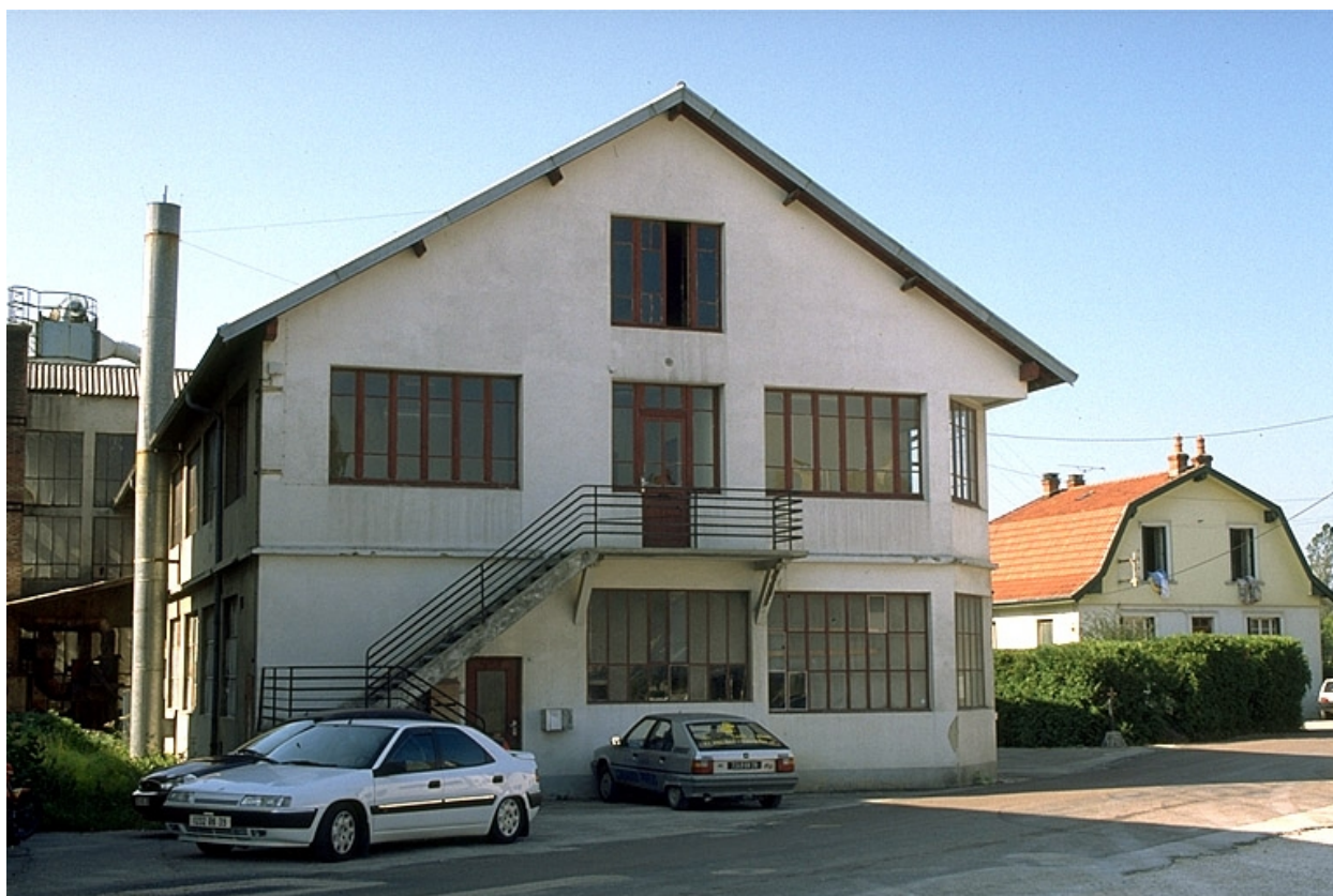
Façade antérieure (bureau).
