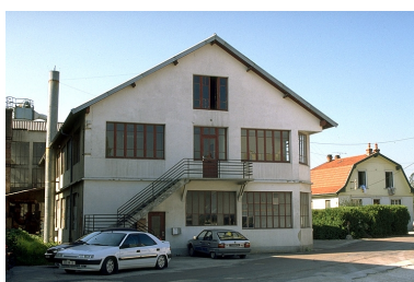
Façade antérieure (bureau).
