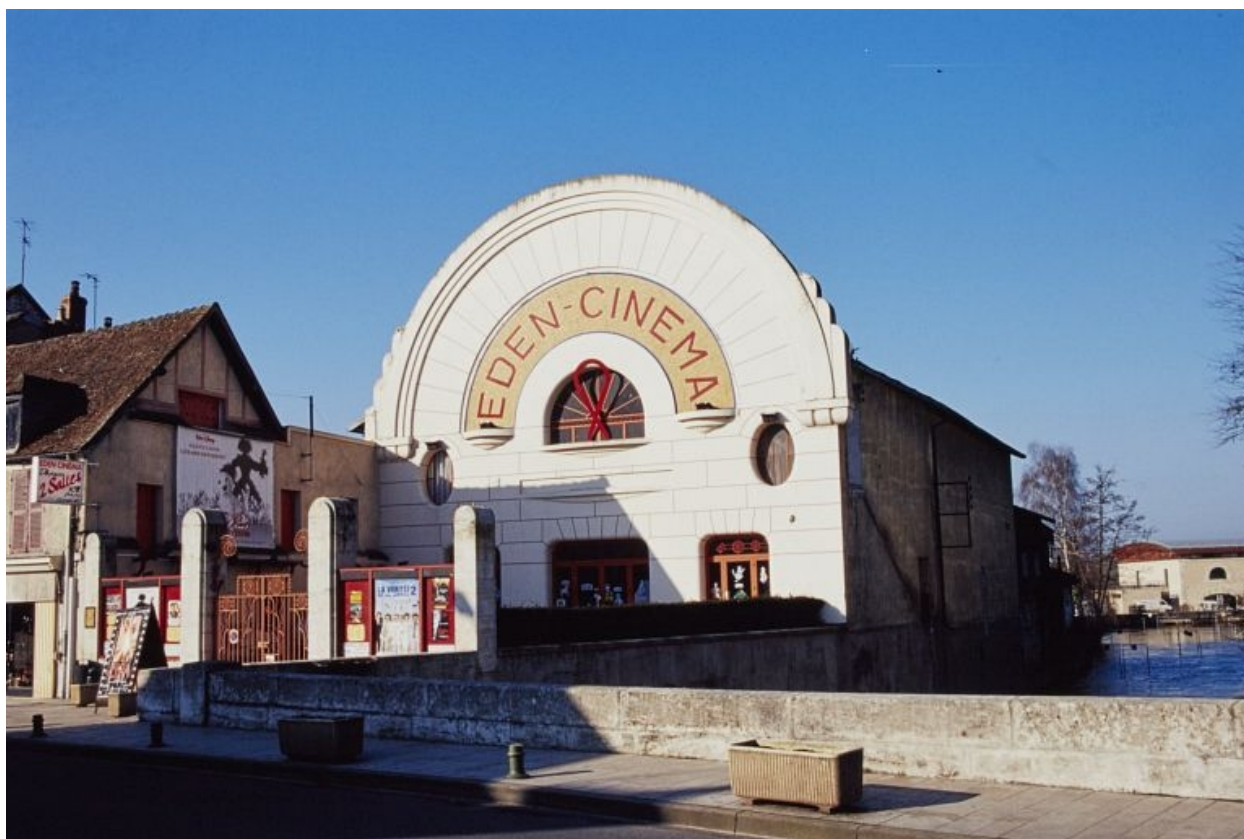
Elévation principale, vue d'ensemble, en 2001.
