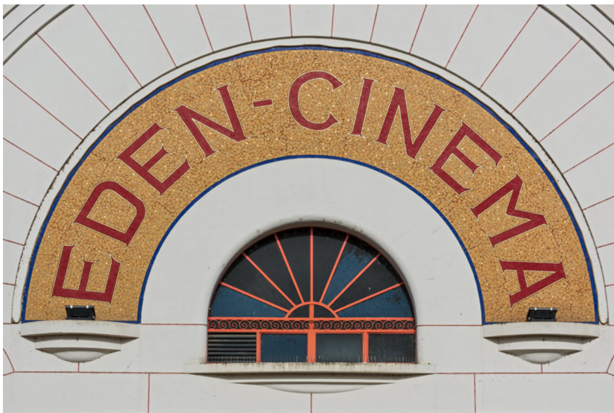
Façade antérieure, partie haute : baie et enseigne.
