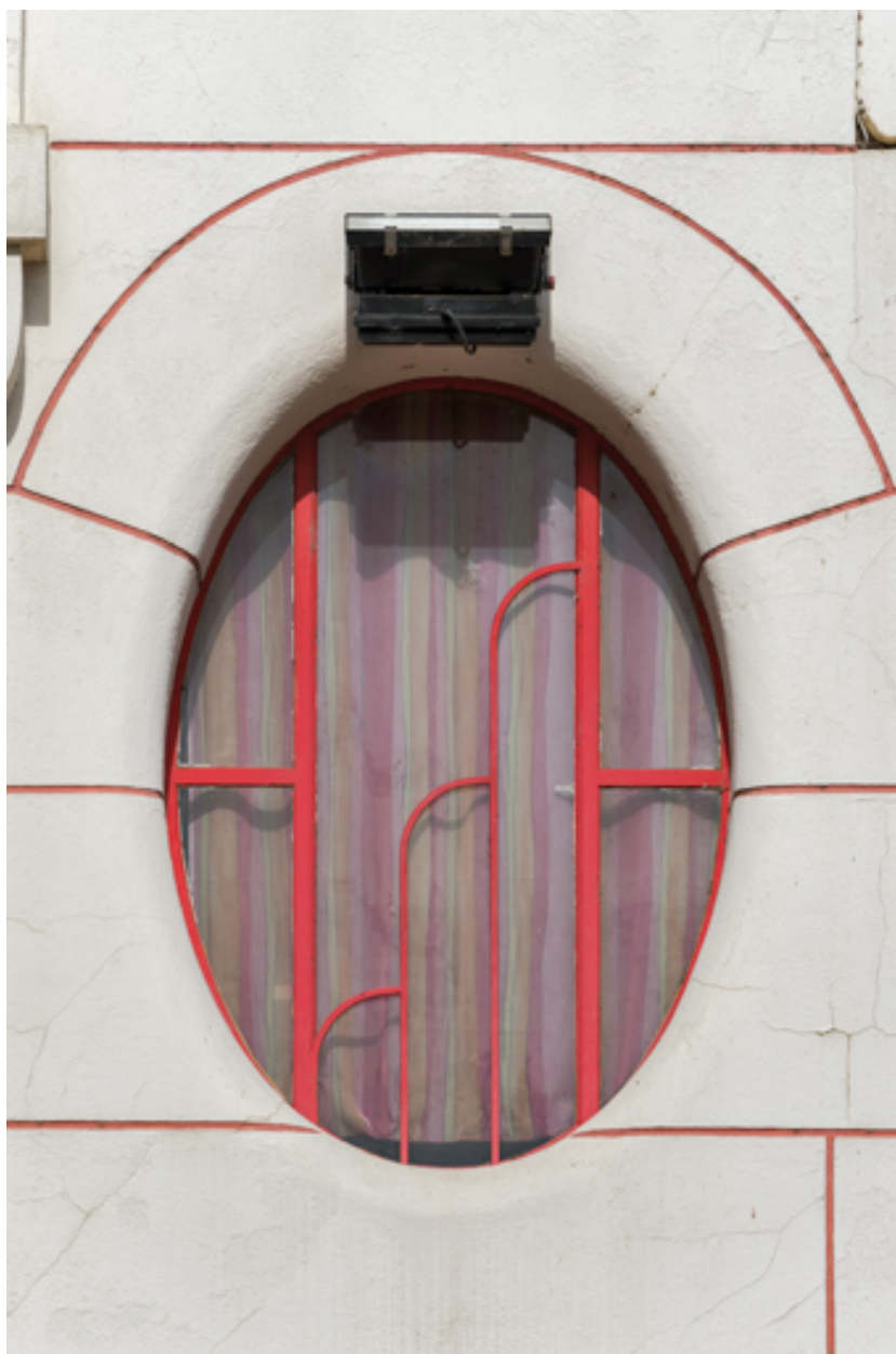
Façade antérieure, partie haute : oculus gauche.
