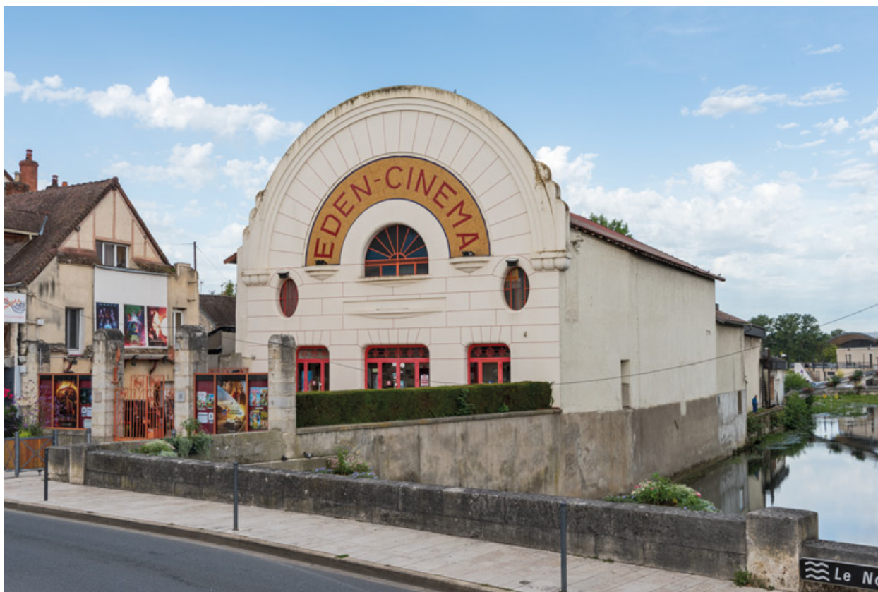
Façades antérieure et latérale droite : cinéma.
