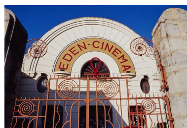
Elévation principale, le fronton et le portail, en 2001. Phot. Jean-Luc Duthu IVR26_20015800072ZA
