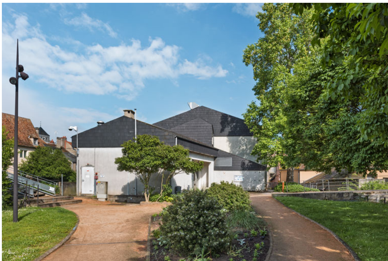
Vue d'ensemble, depuis l'ouest : salle des fêtes.
