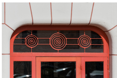
Façade antérieure : feronnerie de la baie centrale. Phot. Pierre-Marie Barbe-Richaud IVR26_20235800194NUC4A
