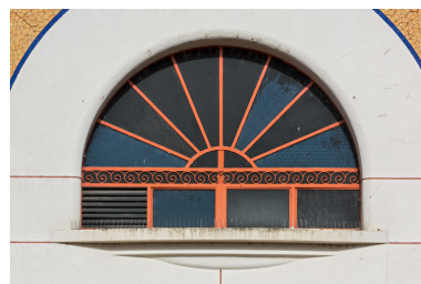
Façade antérieure, partie haute : baie. Phot. Pierre-Marie Barbe-Richaud IVR26_20235800192NUC4A
