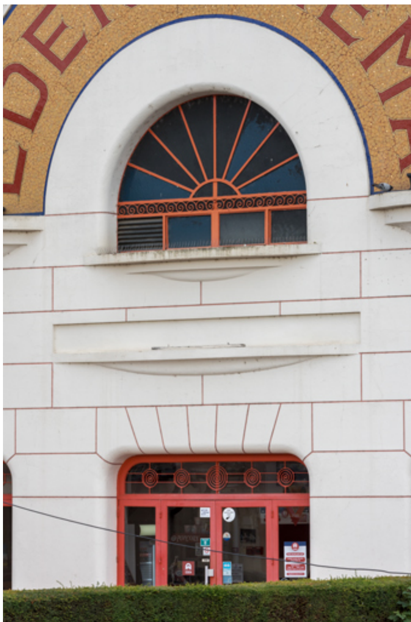
Façade antérieure : baies centrales.
