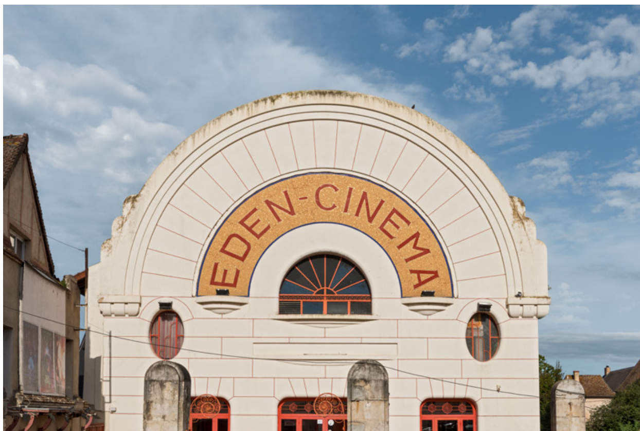
Façade antérieure : partie haute.
