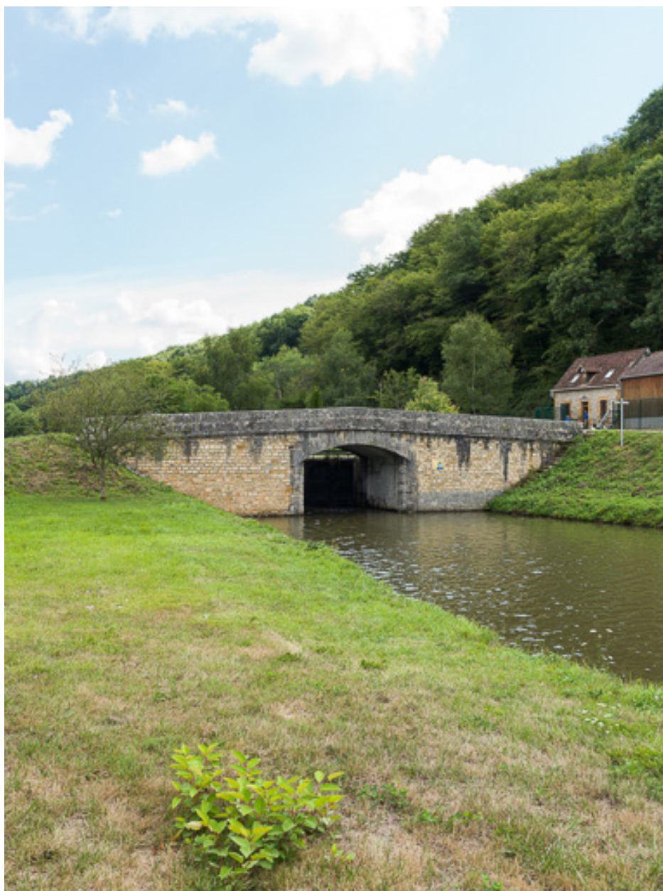
Vue d'ensemble du pont.
