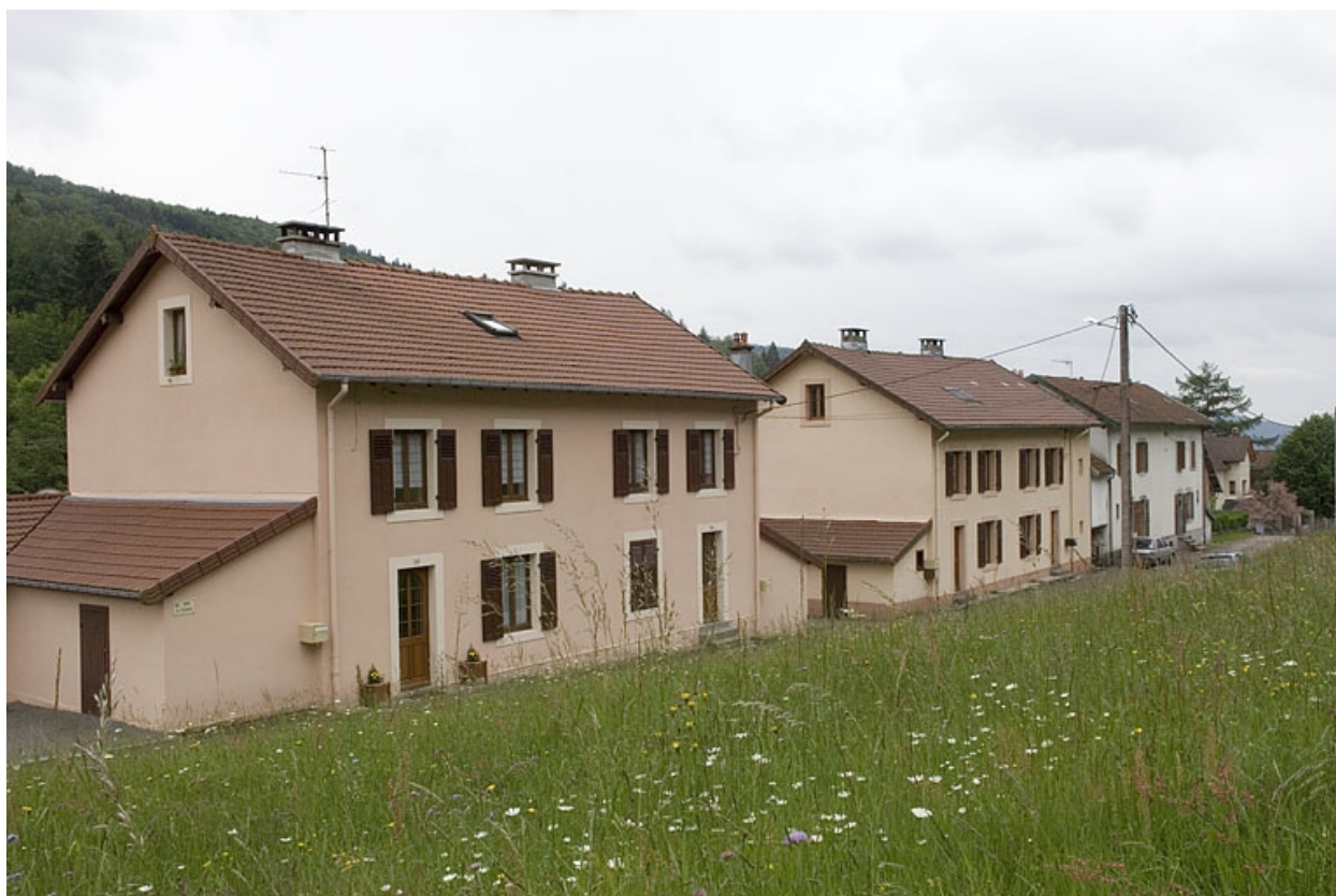
Cité ouvrière (rue de l'Usine).
