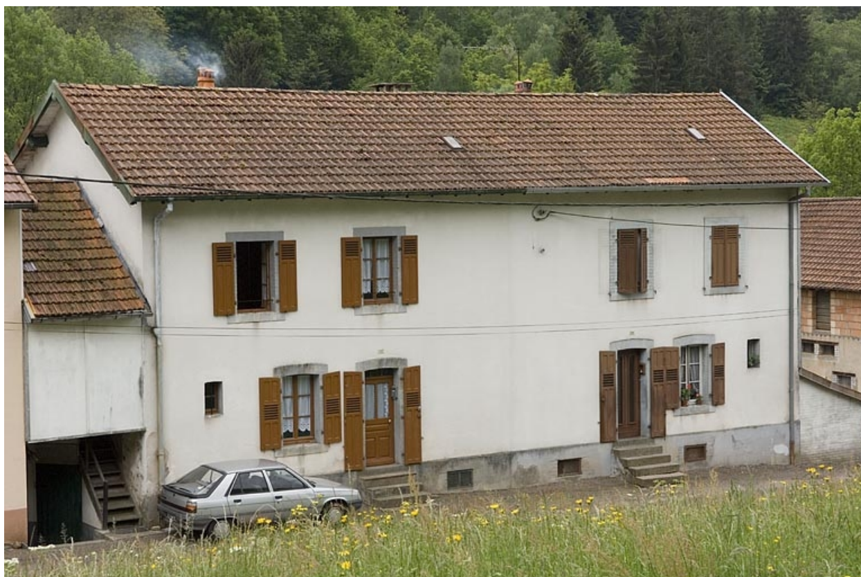
Logement ouvrier collectif (rue de l'Usine).
