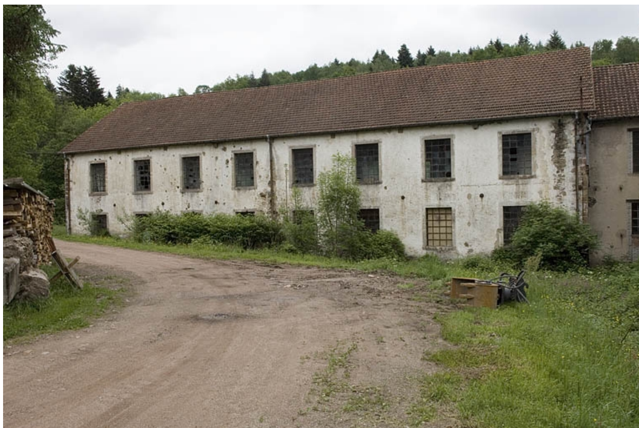
Façade nord-ouest de l'atelier de tissage.
