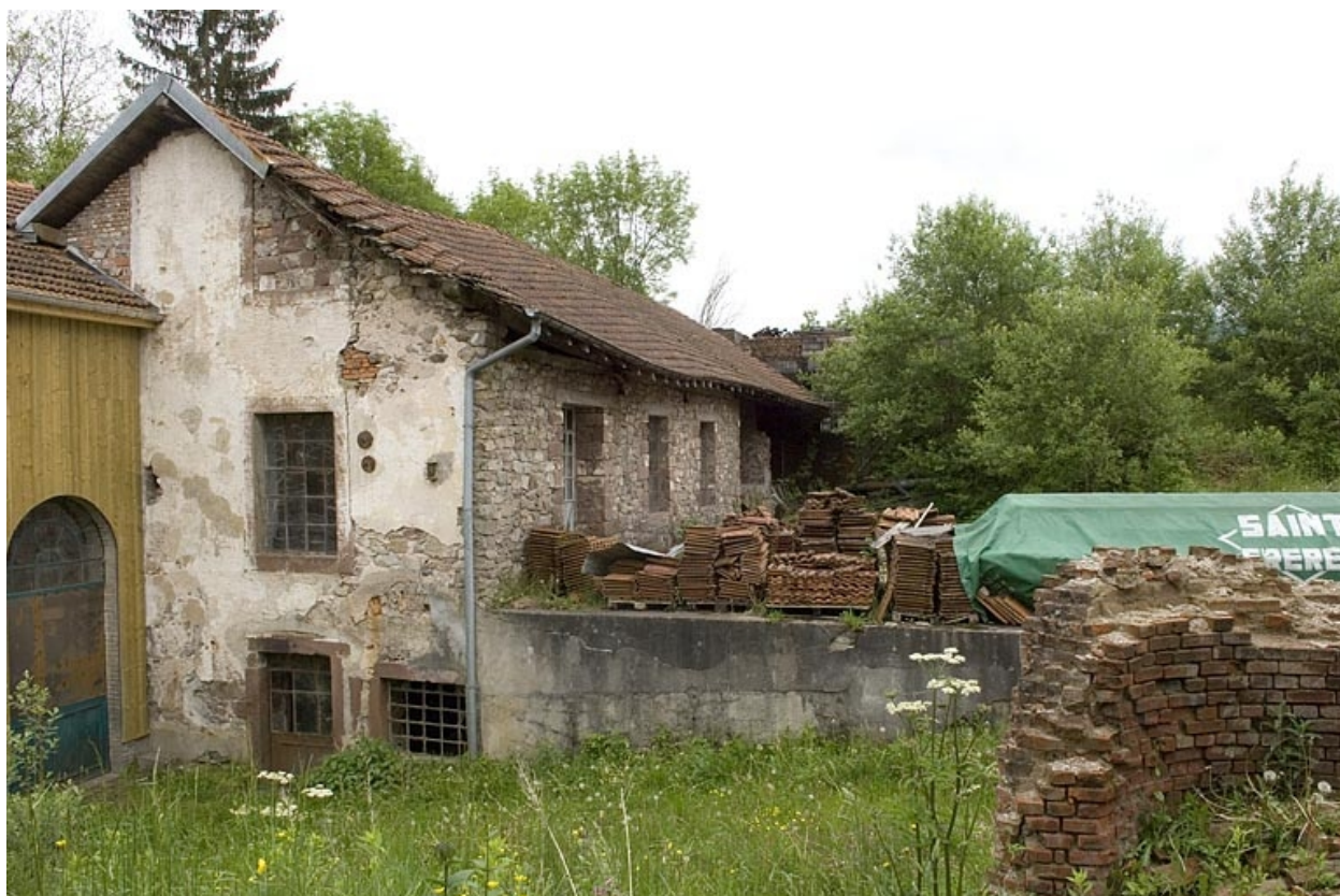
Atelier de réparation (forge et menuiserie).
