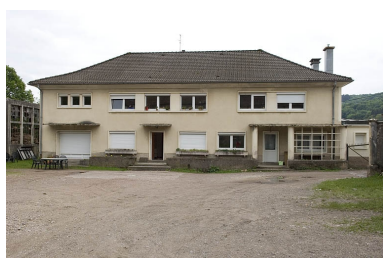
Immeuble de bureaux. Phot. Jérôme Mongreville IVR43_20067000450NUCA
