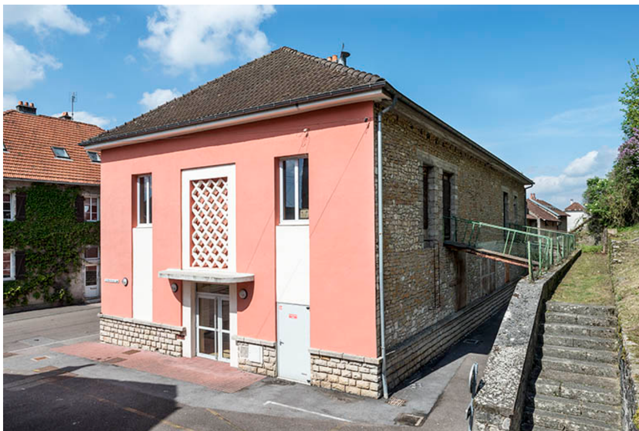
Le mur pignon sud.
