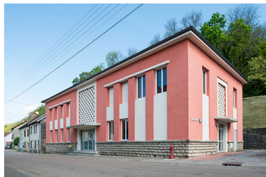
Vue générale de l'édifice. Phot. Jérôme Mongreville IVR43_20177000728NUC4A
