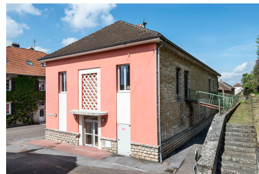
Le mur pignon sud. Phot. Jérôme Mongreville IVR43_20177000730NUC4A
