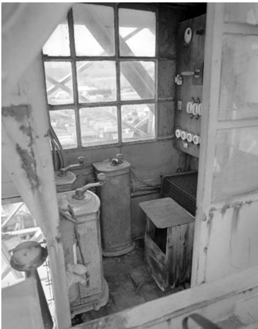
Intérieur de la cabine.
