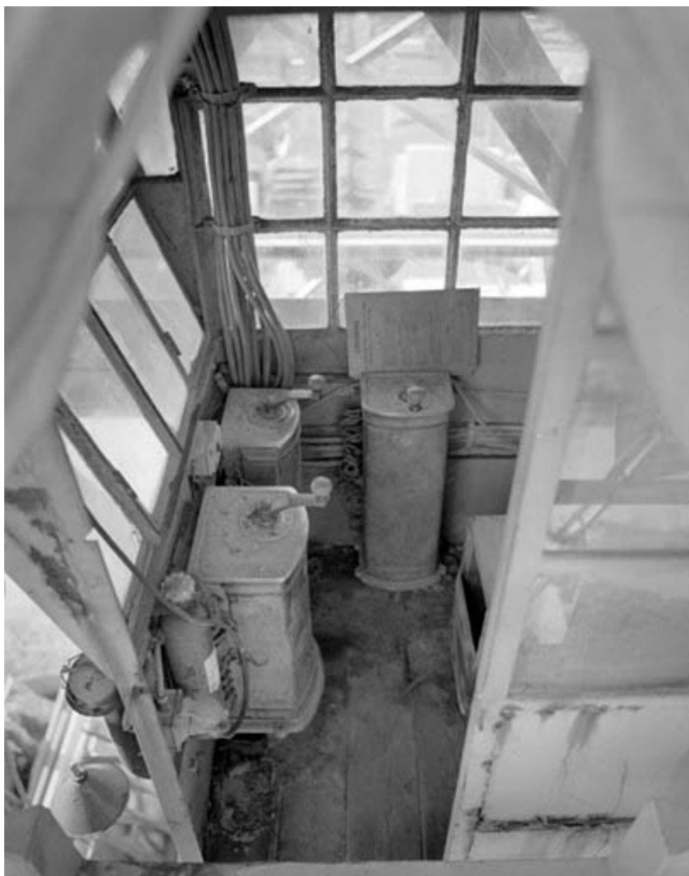
Intérieur de la cabine.
