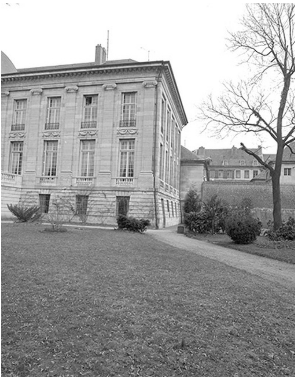
Façade postérieure : détail partie droite.
