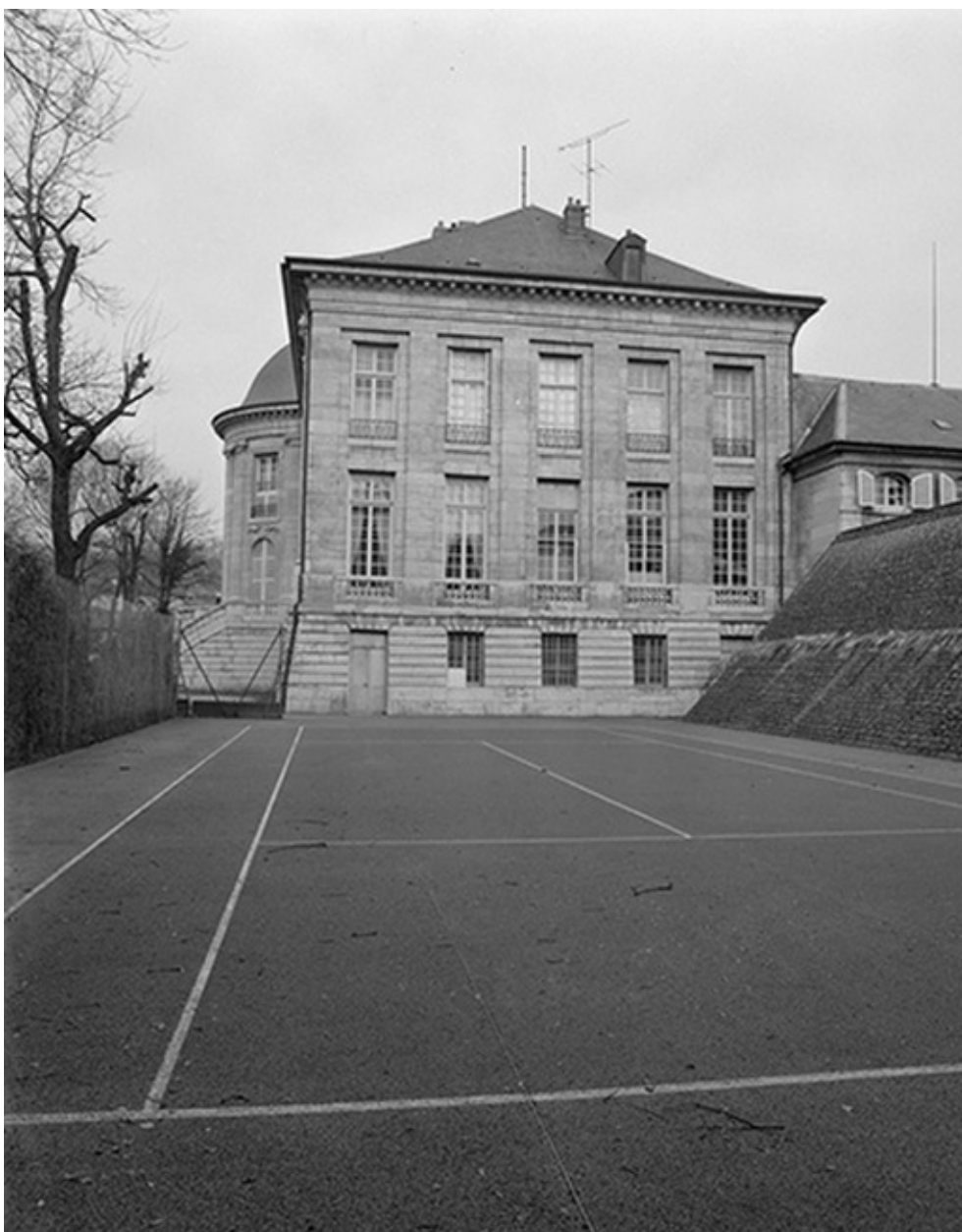
Façade latérale gauche : de face.
