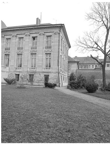
Façade postérieure : détail partie droite.
