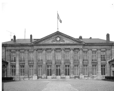
Façade antérieure, de face.
