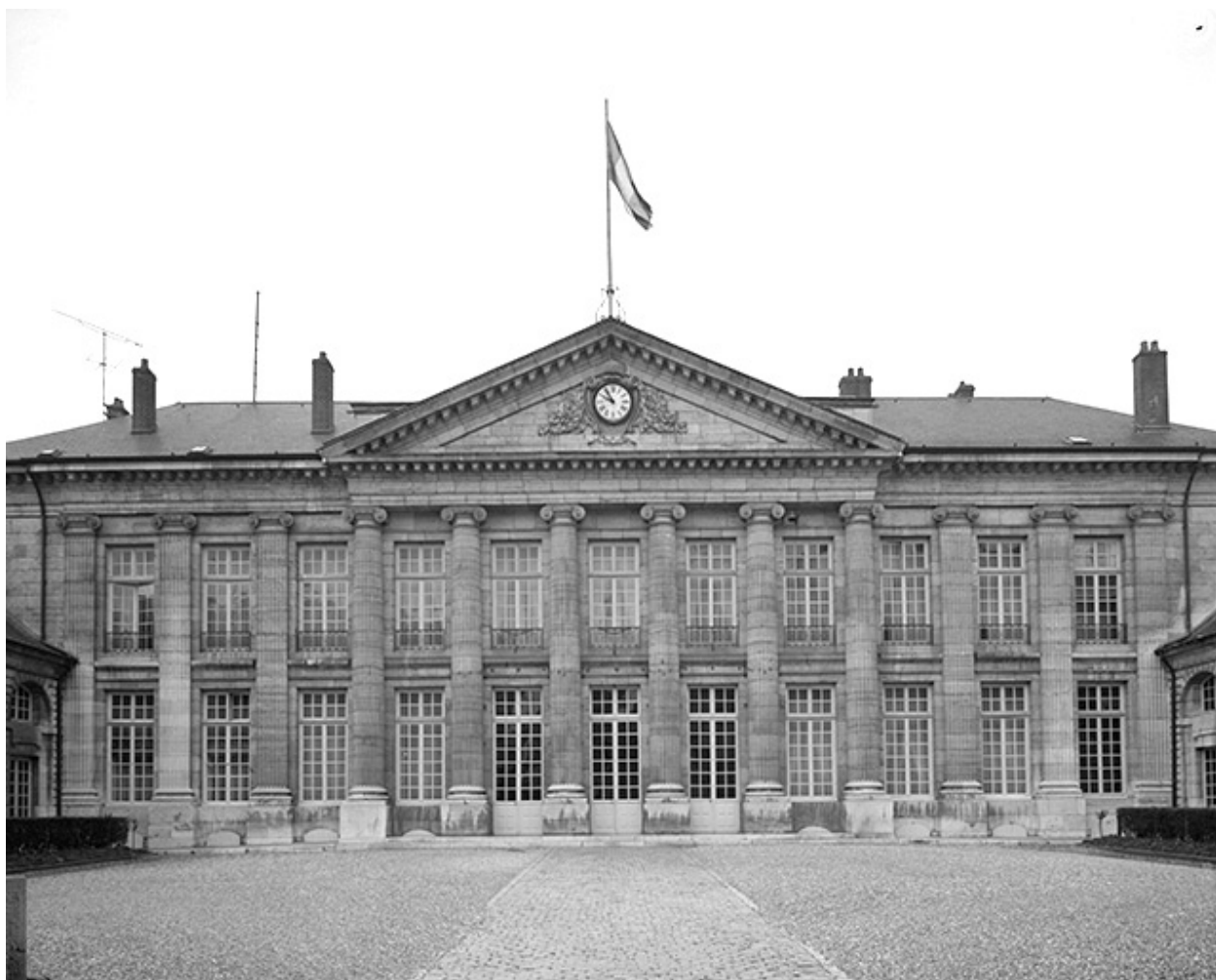
Façade antérieure, de face.
