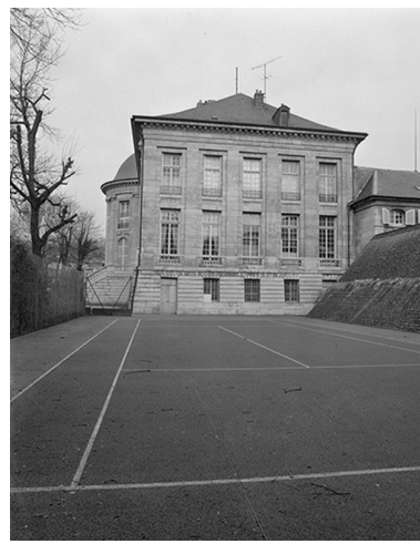
Façade latérale gauche : de face.
