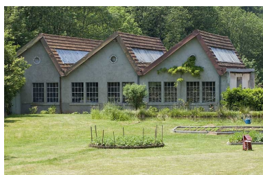
Pignons est de l'atelier de fabrication. Phot. Jérôme Mongreville IVR43_20067000508NUCA
