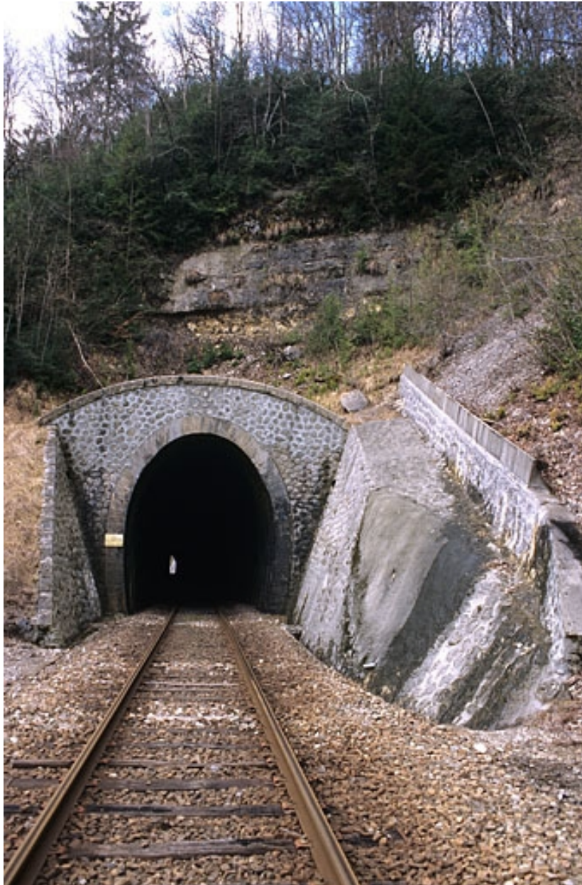
Tunnel des Frettes : tête côté Andelot-en-Montagne (nord).
