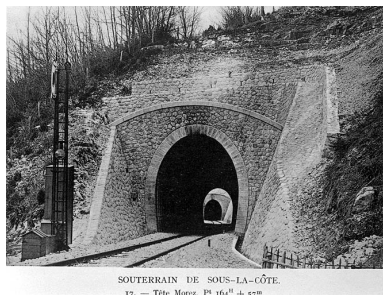
Souterrain de Sous-la-Côte. Tête Morez, [1919]. Phot. Jérôme Mongreville IVR43_20003900812X
