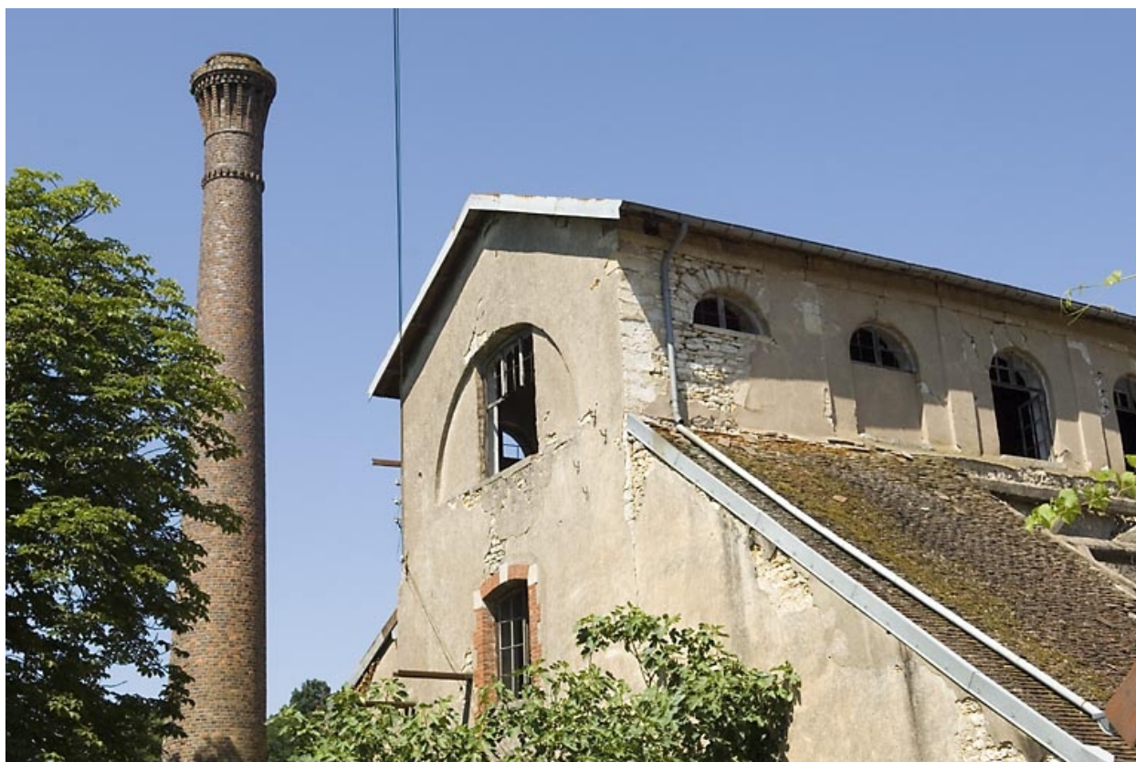
Cheminée et partie supérieure du haut fourneau.
