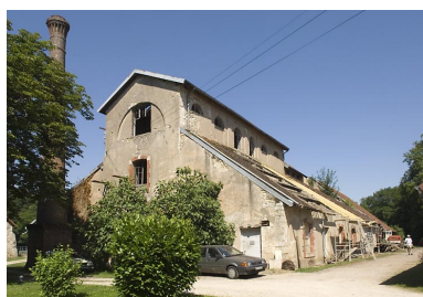
Le haut fourneau vu depuis le sud-est. Phot. Jérôme Mongreville IVR43_20087000671NUC2A
