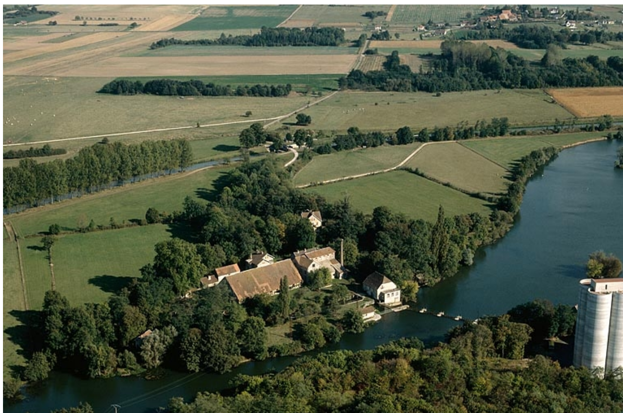
Vue aérienne depuis le nord-ouest en 1989.
