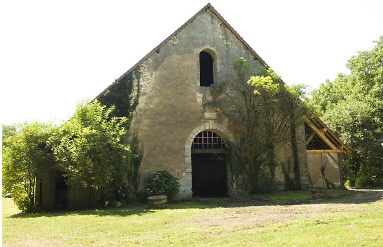
Mur-pignon nord de la halle à charbon.
