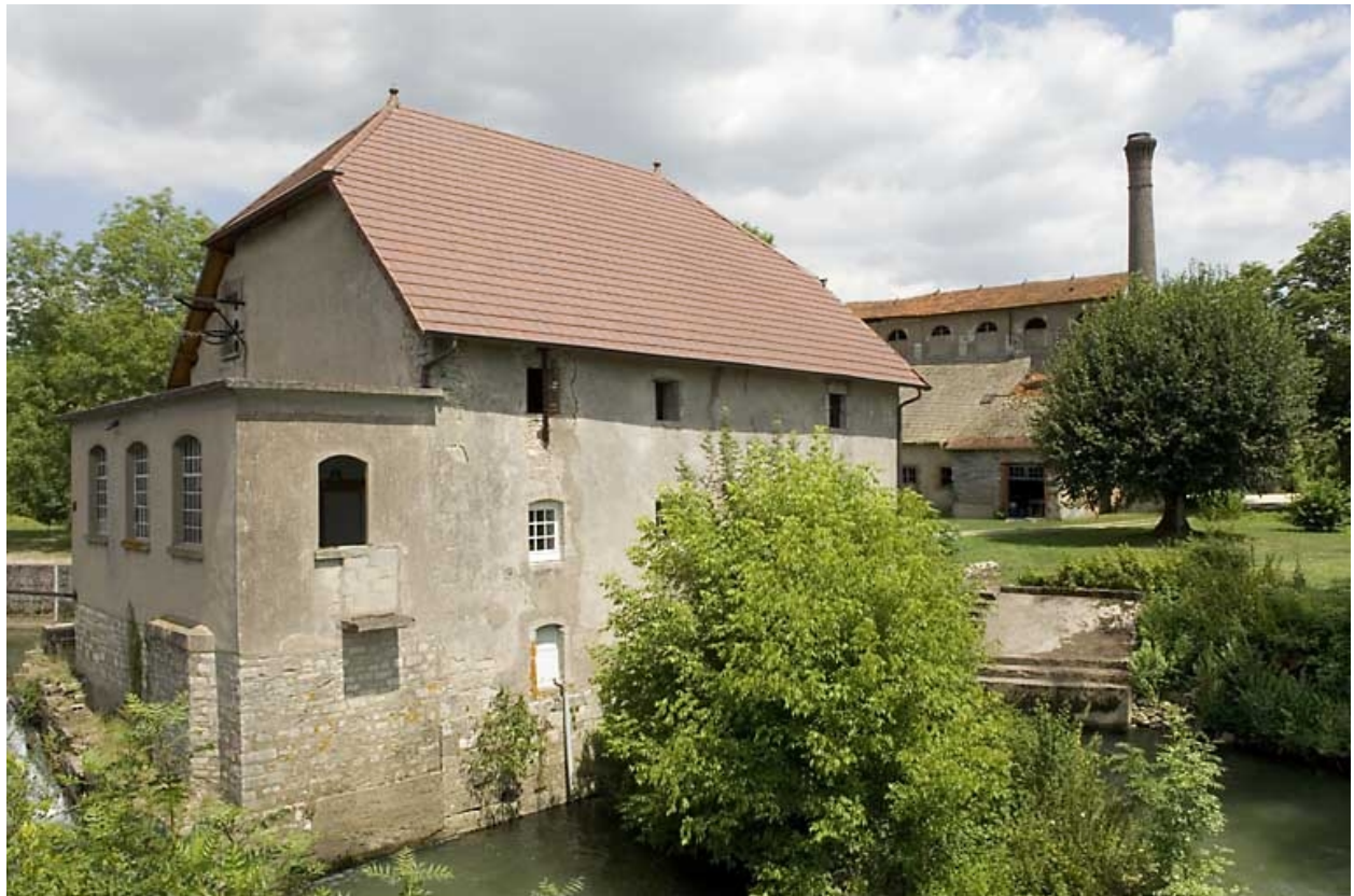
Moulin et haut fourneau depuis le sud-ouest.
