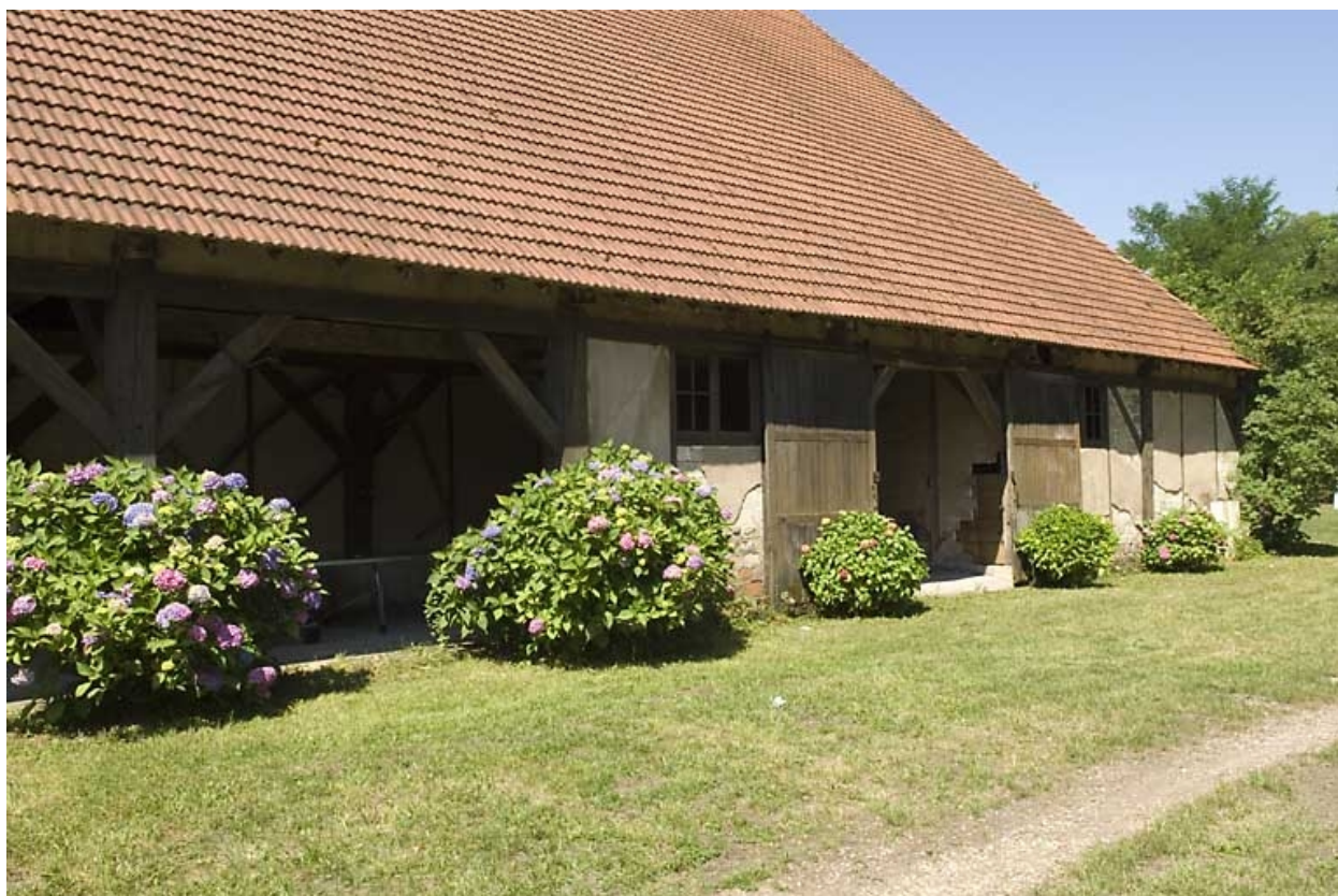
Extrémité nord de la halle à charbon.
