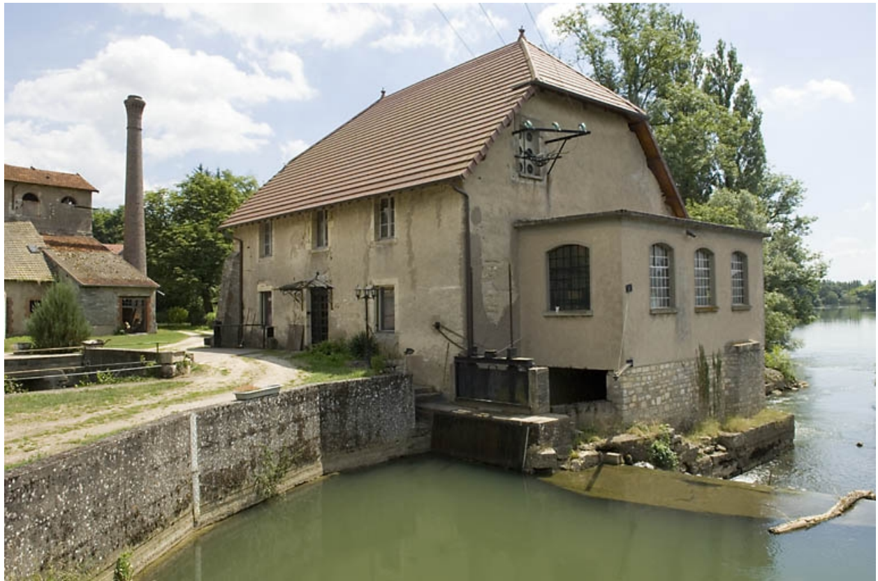
Moulin reconverti en centrale hydroélectrique.
