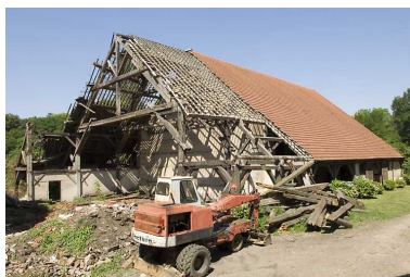
La halle à charbon vue depuis l'est. Phot. Jérôme Mongreville IVR43_20087000674NUC2A
