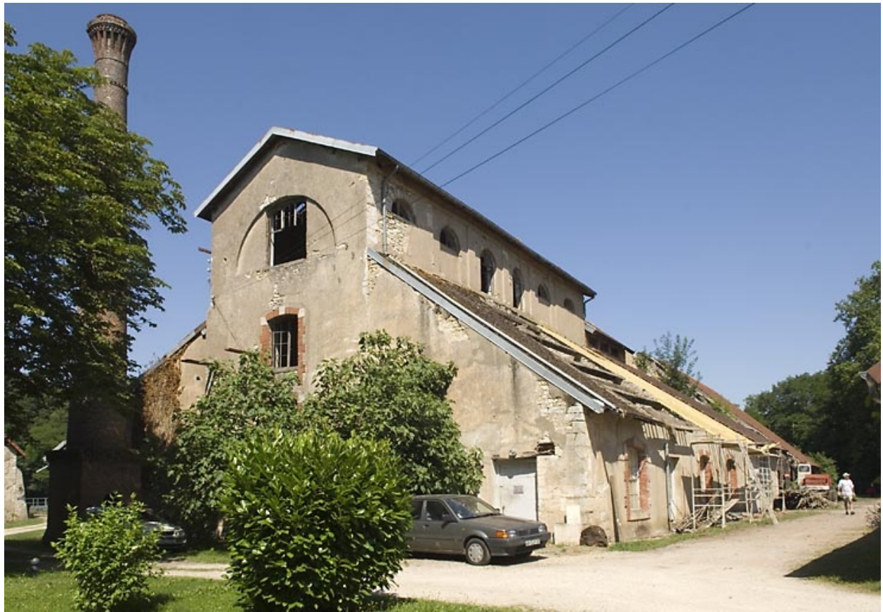
Le haut fourneau vu depuis le sud-est.
