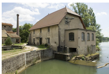
Moulin reconverti en centrale hydroélectrique. Phot. Jérôme Mongreville IVR43_20087000682NUC2A
