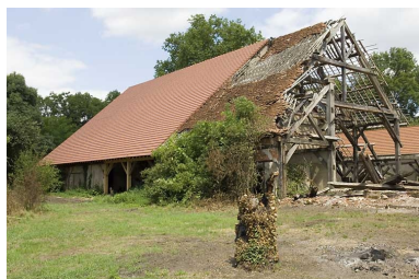
La halle à charbon vue depuis le sud. Phot. Jérôme Mongreville IVR43_20087000686NUC2A
