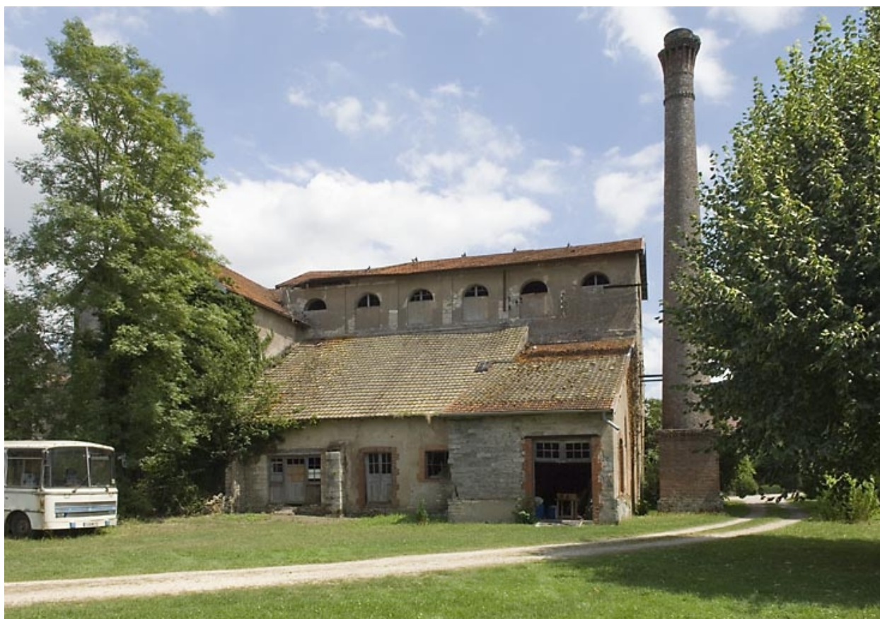
Elévation ouest du haut fourneau.
