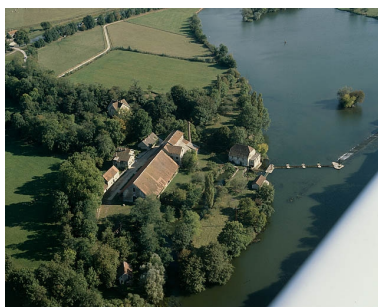
Vue aérienne plongeante depuis le nord en 1989. Phot. Yves Sancey IVR43_19897000590XA
