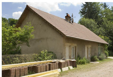
Logement à l'entrée du site. Phot. Jérôme Mongreville IVR43_20087000689NUC2A
