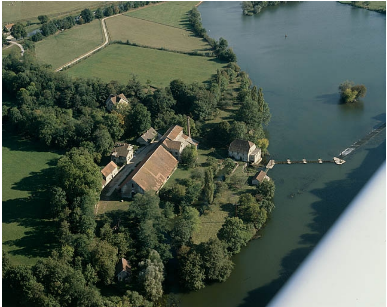
Vue aérienne plongeante depuis le nord en 1989.
