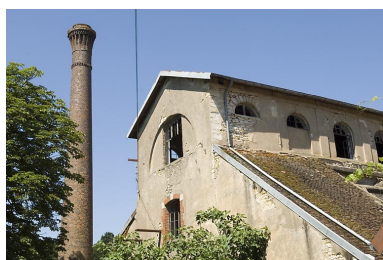
Cheminée et partie supérieure du haut fourneau. Phot. Jérôme Mongreville IVR43_20087000680NUC2A
