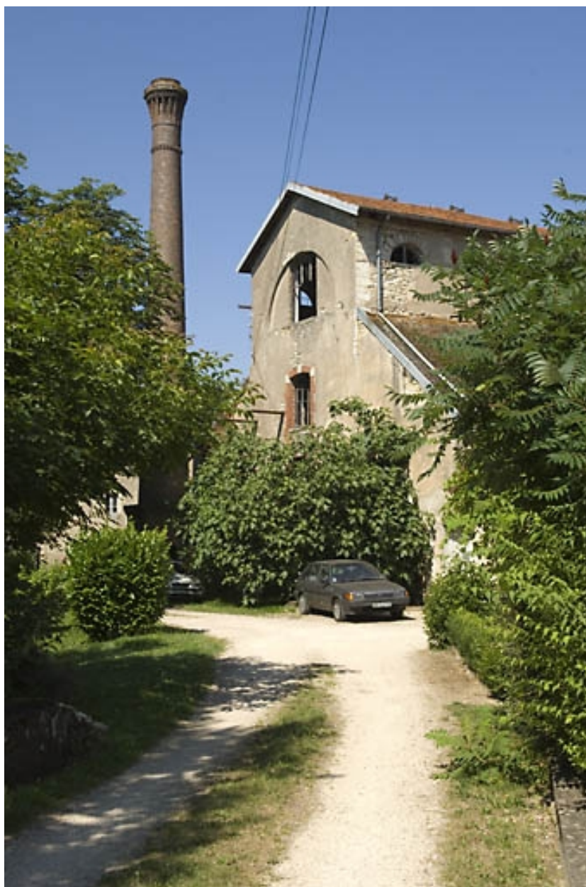
Vue du haut fourneau depuis l'entrée.
