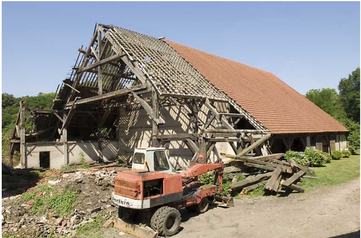
La halle à charbon vue depuis l'est.
