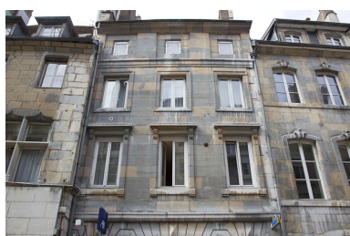
Façade antérieure : détail des étages, de face.
