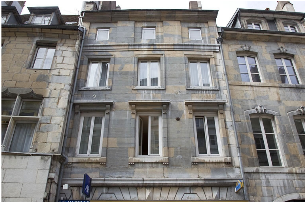
Façade antérieure : détail des étages, de face.
