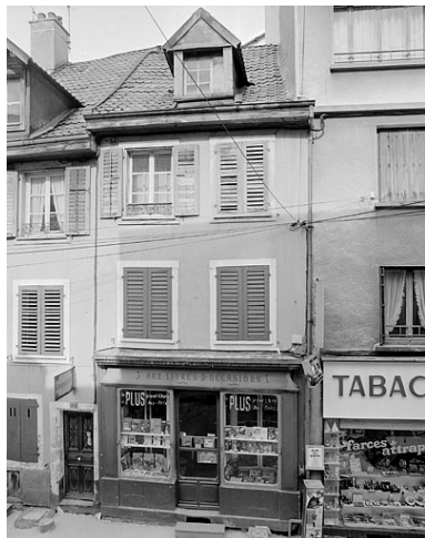
Façade sur rue. Phot. Jérôme Mongreville IVR43_19872500957X
