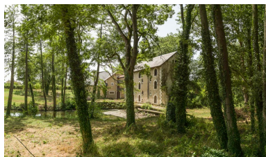
Vue d'ensemble du moulin. Phot. Pierre-Marie Barbe-Richaud
