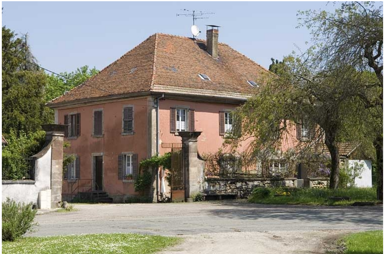
Saline de Gouhenans : bâtiment des bureaux.
