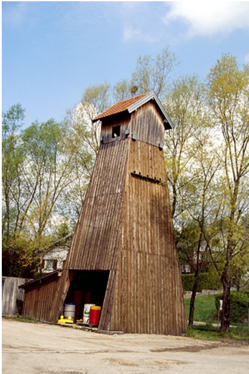
Saline de Montmorot : chevalement du puits n° 7 en.
