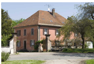
Saline de Gouhenans : bâtiment des bureaux. Phot. Jérôme Mongreville IVR43_20067000252NUCA
