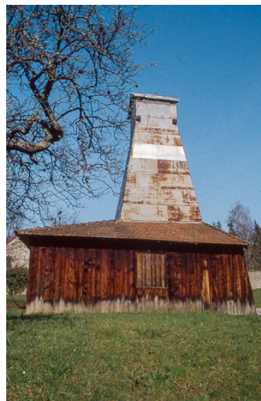
Saline de Miserey-Salines : puits de sondage nord. Phot. Yves Sancey IVR43_19992500054ZA
