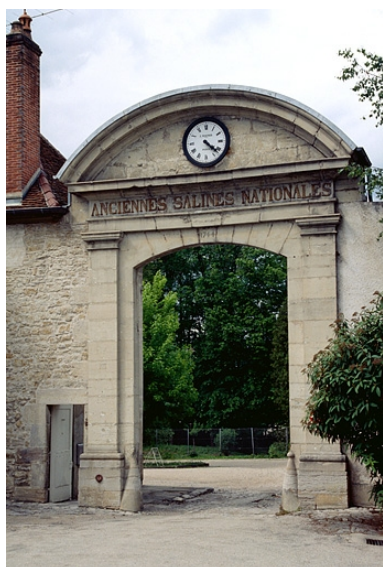
Saline de Montmorot : portail d'entrée. Phot. Jérôme Mongreville IVR43_19963900558ZA
