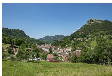
La ville de Salins-les- Bains, protégée par ses forts. Phot. Jérôme Mongreville IVR43_20203900066NUC4A
