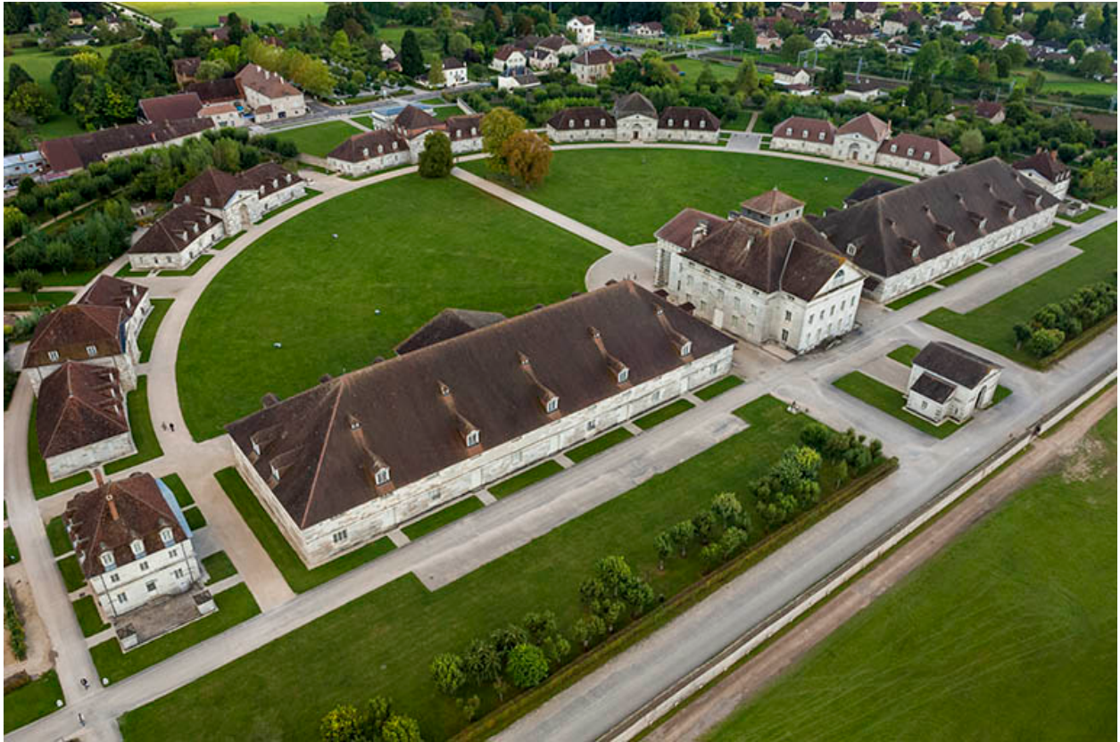
Saline d'Arc-et-Senans : vue aérienne depuis le sud.
