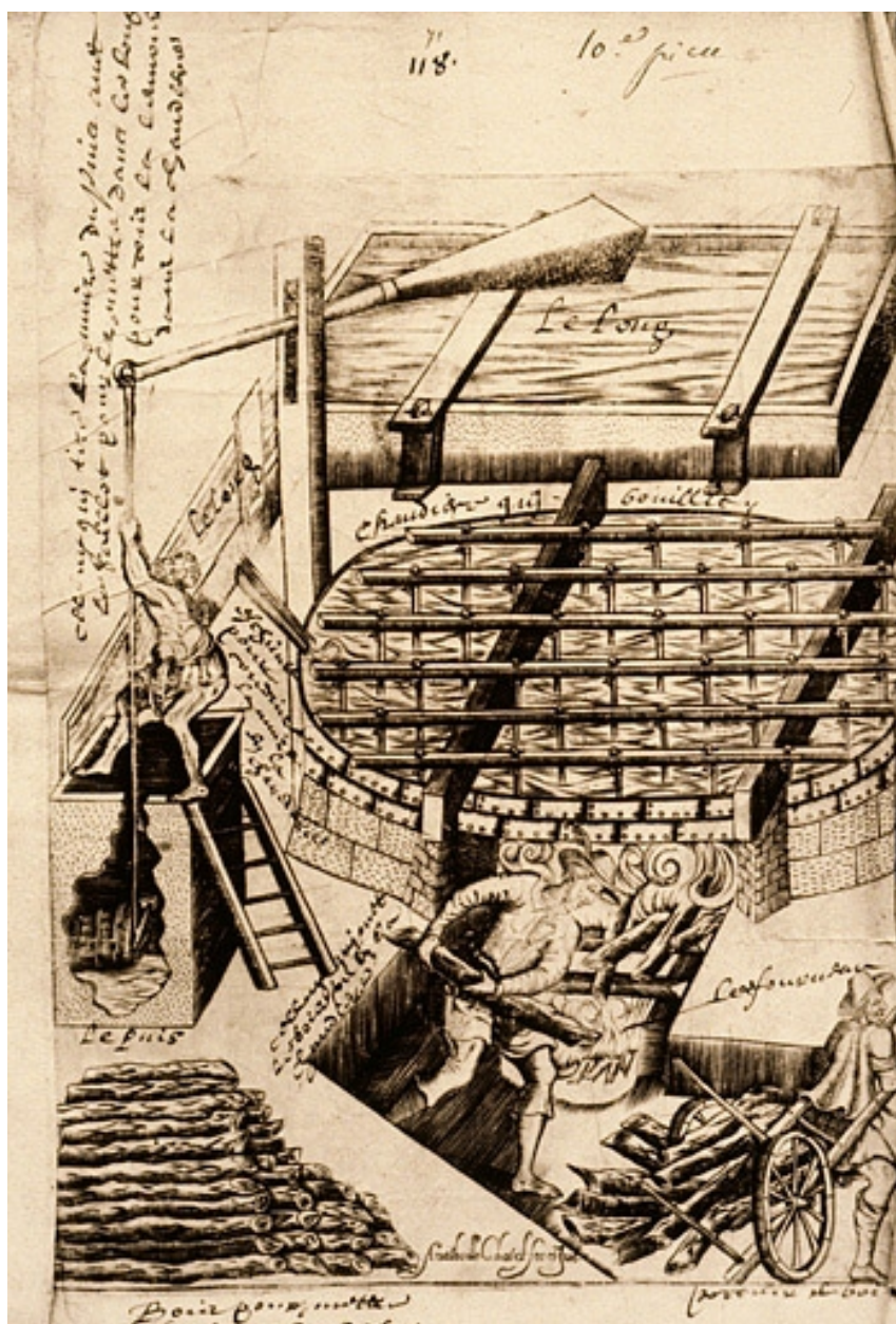
Chaudière pour l'évaporation de la saumure à la saline de Salins, [début 17e siècle]
