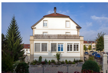
Façade latérale gauche, avec l'atelier.
