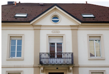
Façade antérieure : premier étage.
