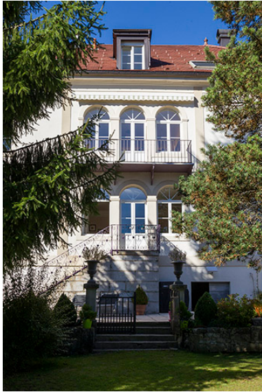
Façade postérieure : travée centrale. Phot. Yves Sancey IVR43_20132502065NUC2A
