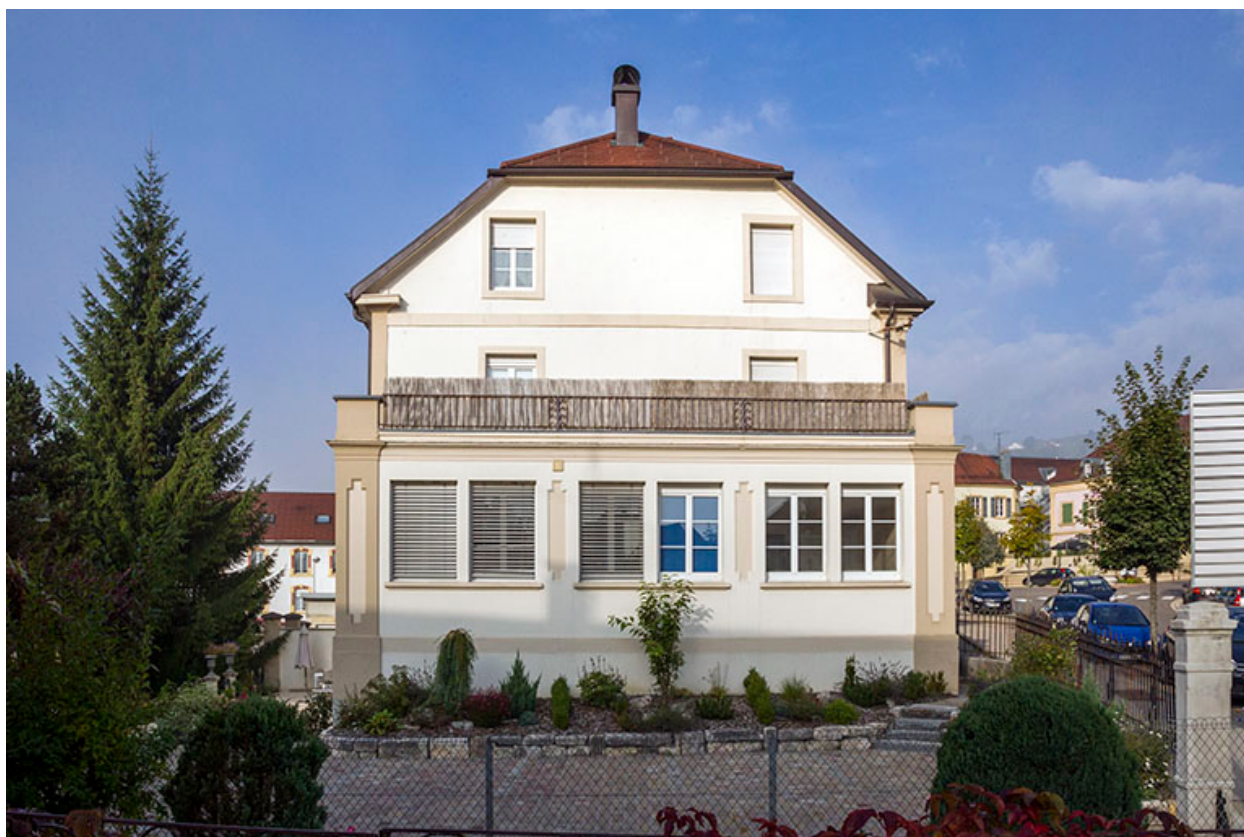
Façade latérale gauche, avec l'atelier.
