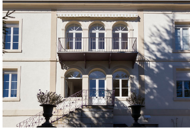
Façade postérieure : baies de la travée centrale. Phot. Yves Sancey IVR43_20132502066NUC2A
