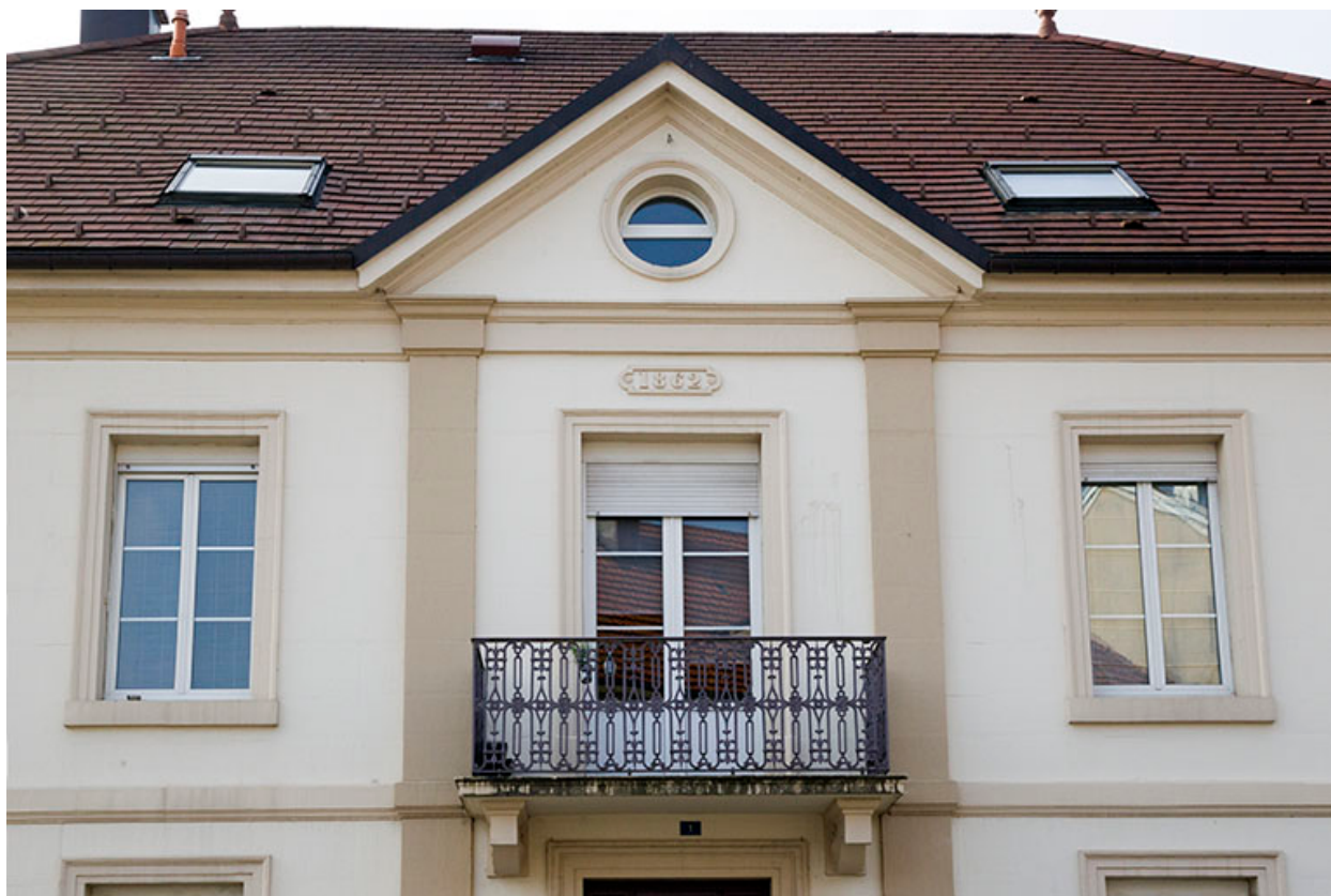
Façade antérieure : premier étage.
