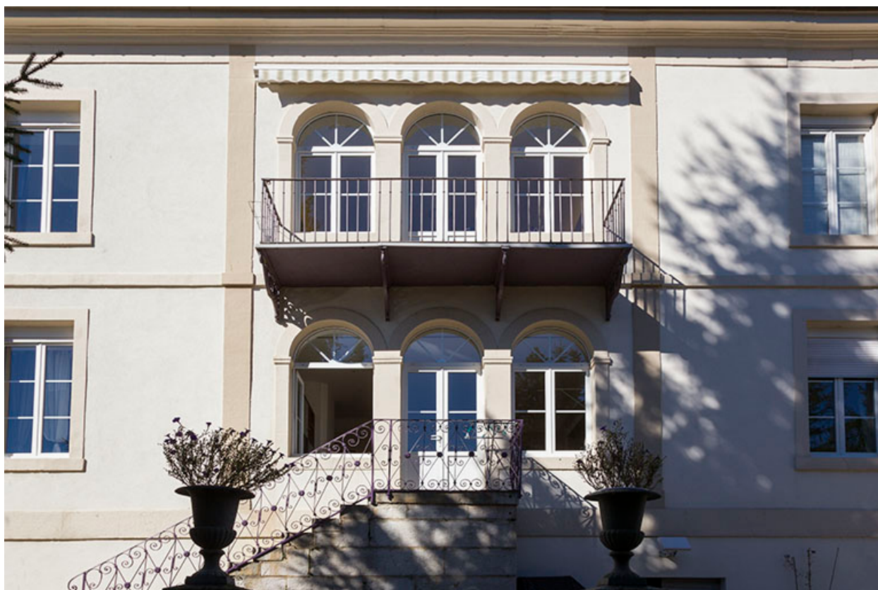
Façade postérieure : baies de la travée centrale.
