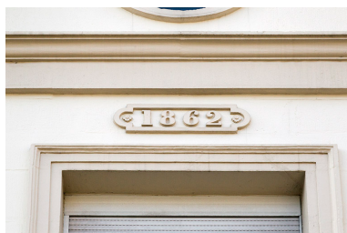
Façade antérieure : date 1862 au premier étage.
