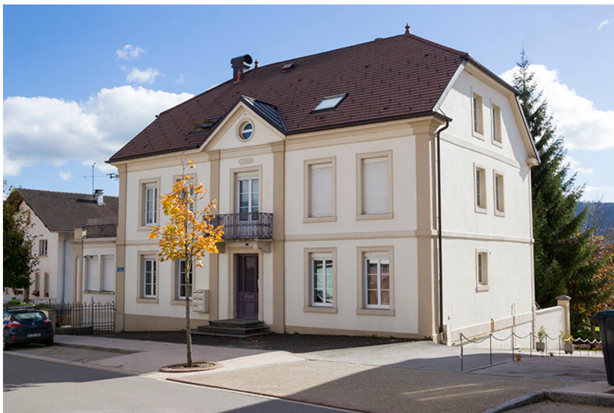
Façades antérieure et latérale droite.
