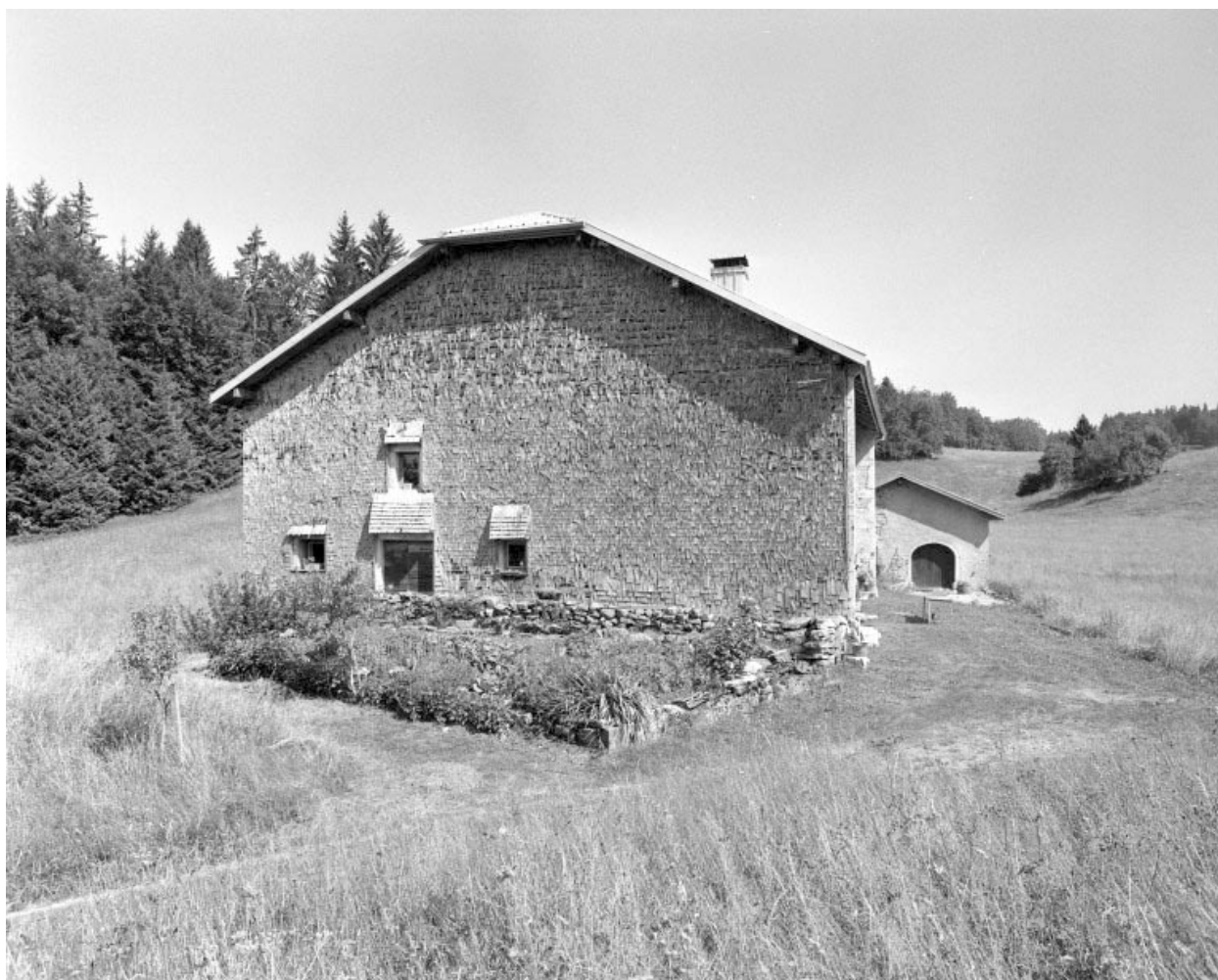
Face gauche recouverte d'un essentage de tavaillons.
