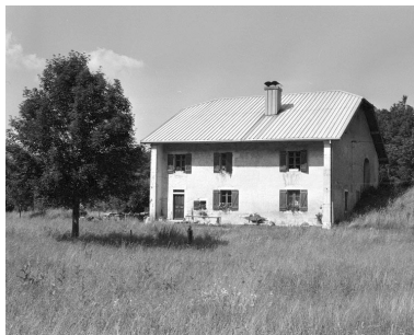
Façade antérieure. Phot. Jérôme Mongreville IVR43_19943900798X
