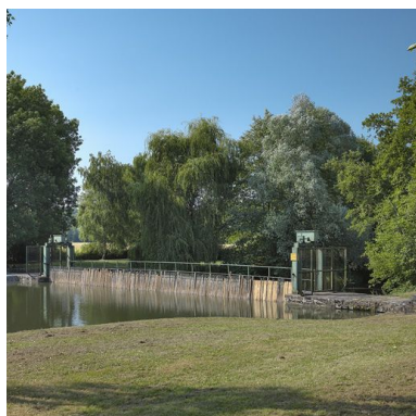
Vue rapprochée du barrage. Phot. Thierry Kuntz IVR26_20135800226NUC4A
