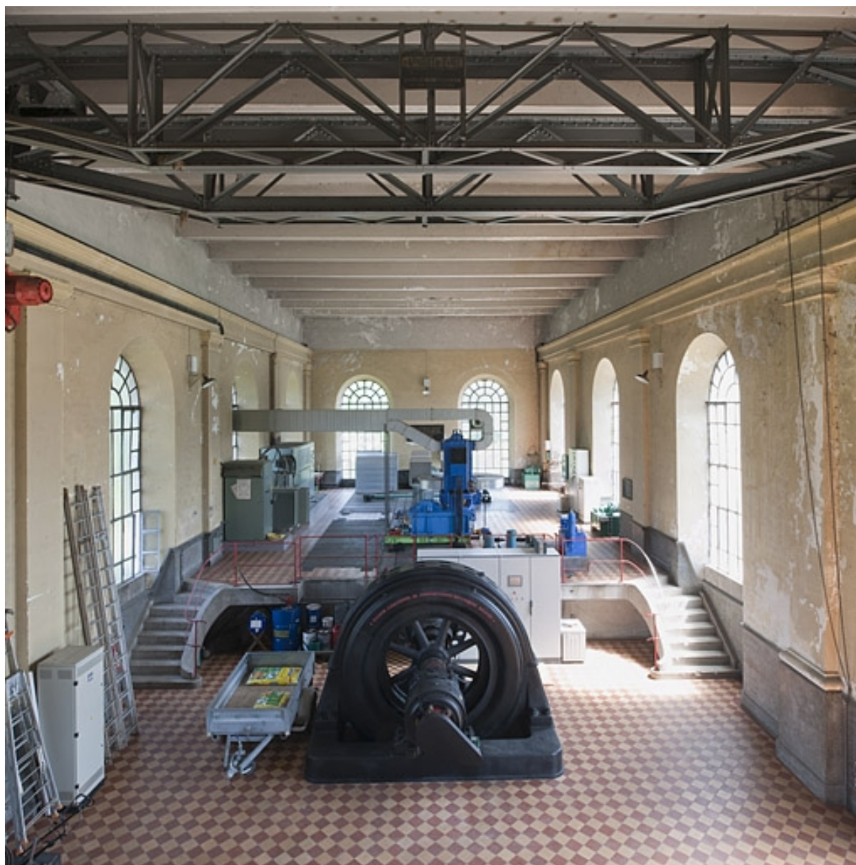
Vue intérieure, depuis le nord-ouest.
