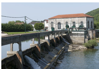
Les déversoirs du barrage et la centrale. Phot. Jérôme Mongreville IVR43_20122501789NUC4A
