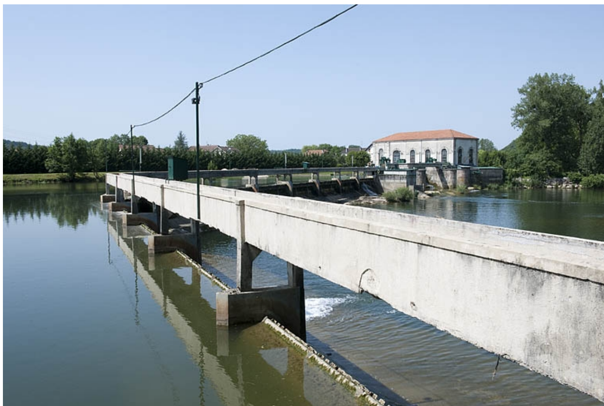
Vue éloignée depuis l'amont du barrage.
