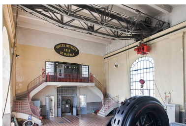
Extrémité nord-ouest de la centrale. Phot. Jérôme Mongreville IVR43_20122501786NUC4A
