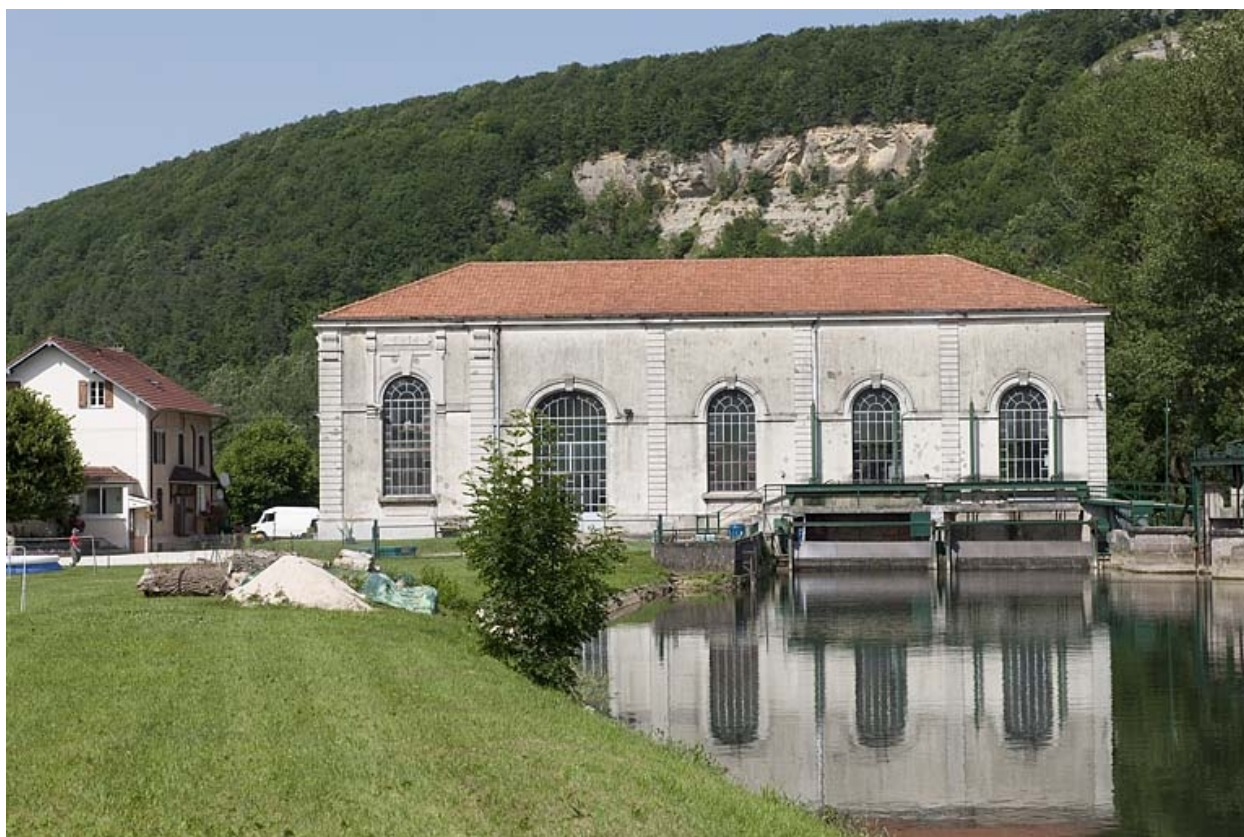
Façade sud de la centrale.
