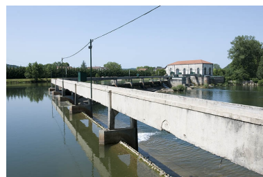
Vue éloignée depuis l'amont du barrage. Phot. Jérôme Mongreville IVR43_20122501787NUC4A
