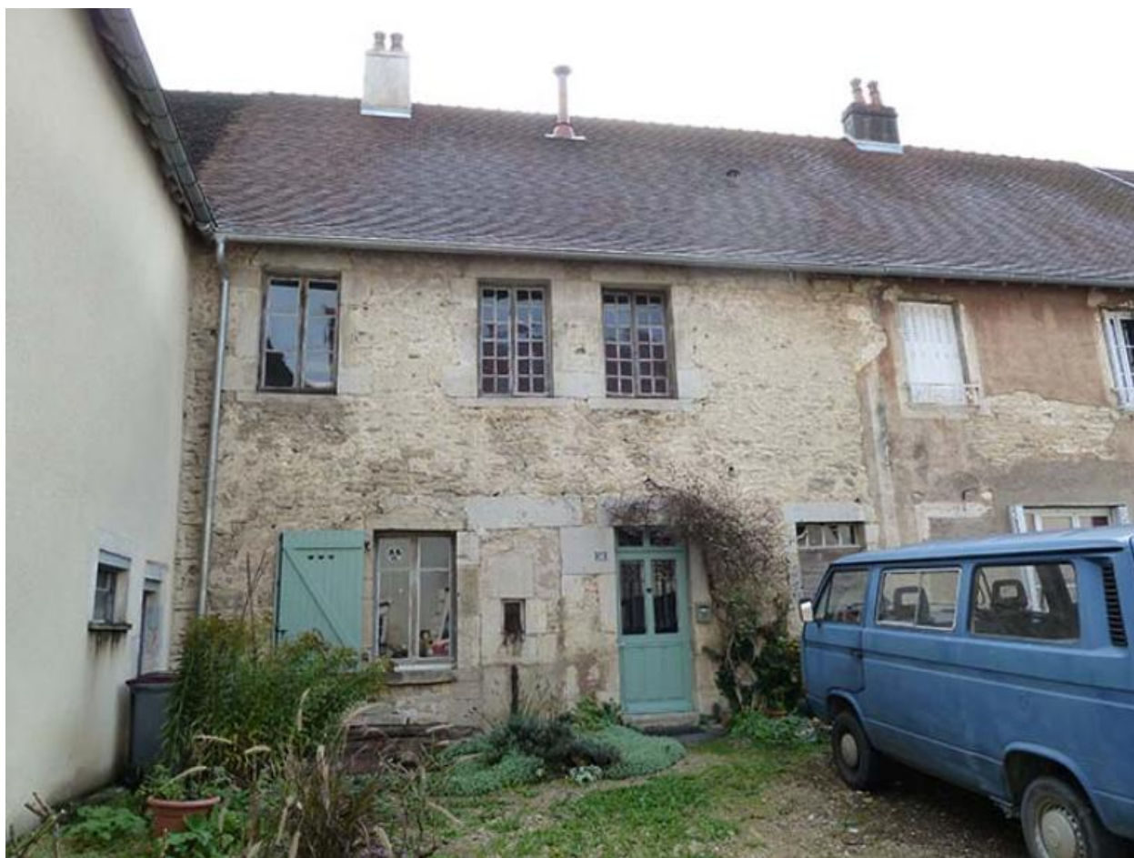
Vue générale nord-ouest
