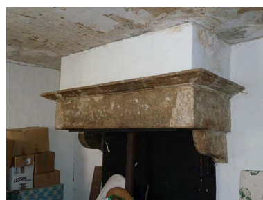
Cheminée de l'étage Phot. Sabrina Dalibard IVR43_20137000857NUC2A
