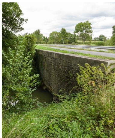
Vue de l'aqueduc.
