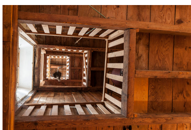
Chevêtres du monte-sac. Phot. Jérôme Mongreville IVR43_20162500268NUC4A
