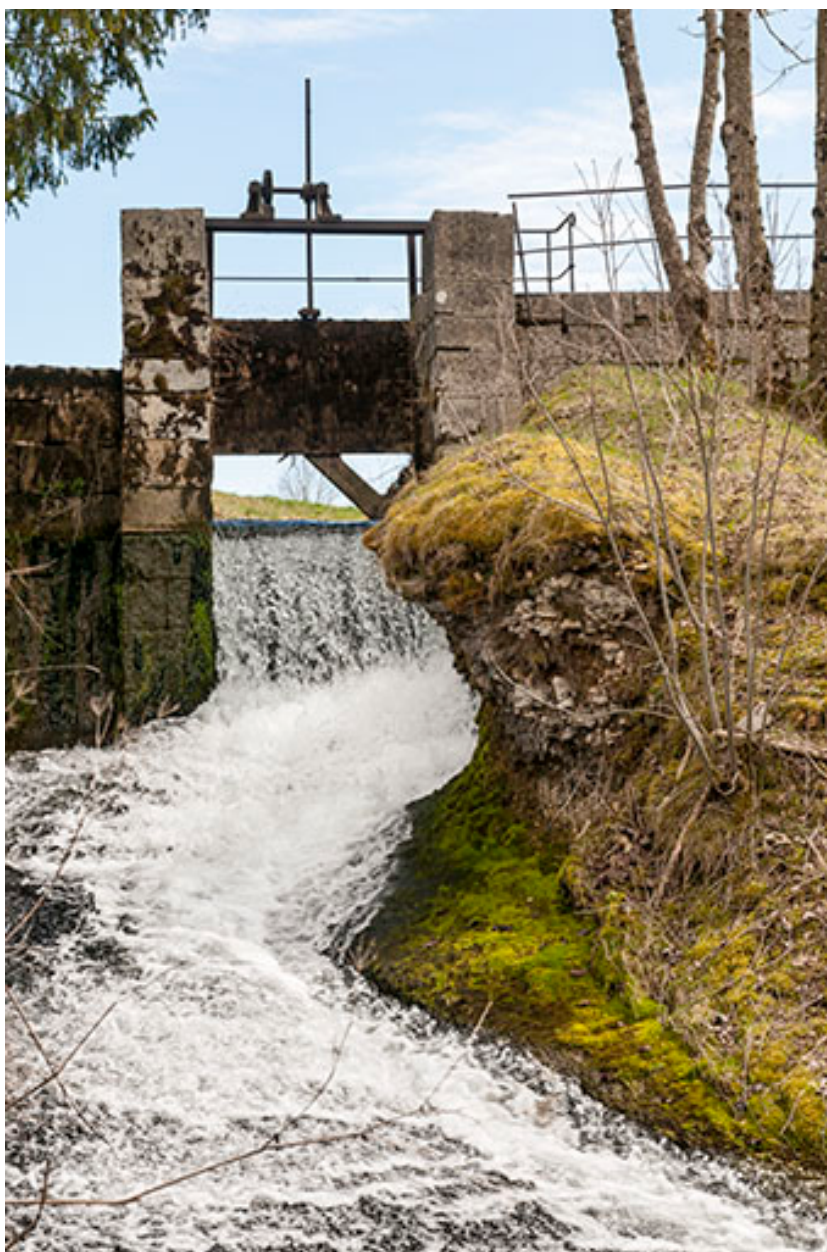
Vanne de décharge sur le Bief Rouge.
