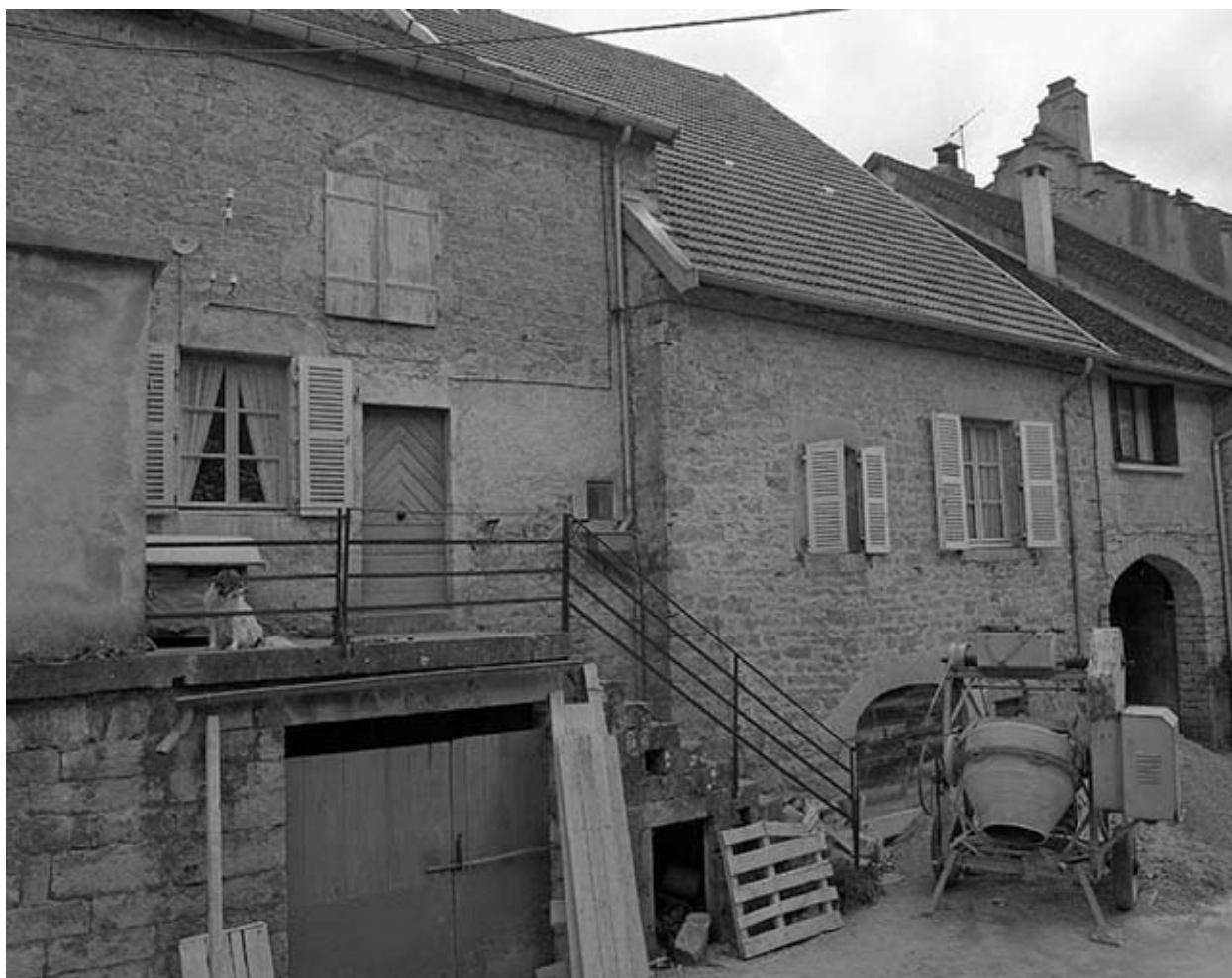
Façade sur l'impasse du quart d'Amont.
