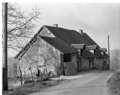
Maison située rue Bouillod. Phot. Jérôme Mongreville IVR43_19853900055X
