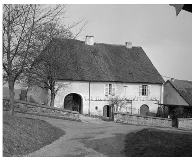
Ferme située rue de la Grappe. Phot. Jérôme Mongreville IVR43_19853900058X
