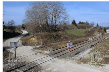
Vue d'ensemble. Phot. Yves Sancey IVR43_20053900262ZA
