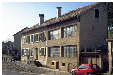
Façade antérieure. Phot. Laurent Poupard IVR43_19913901032ZA
