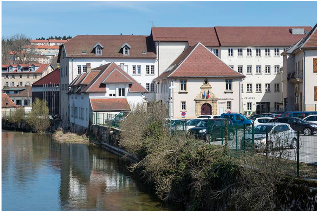
Vue rapprochée depuis le sud-ouest.
