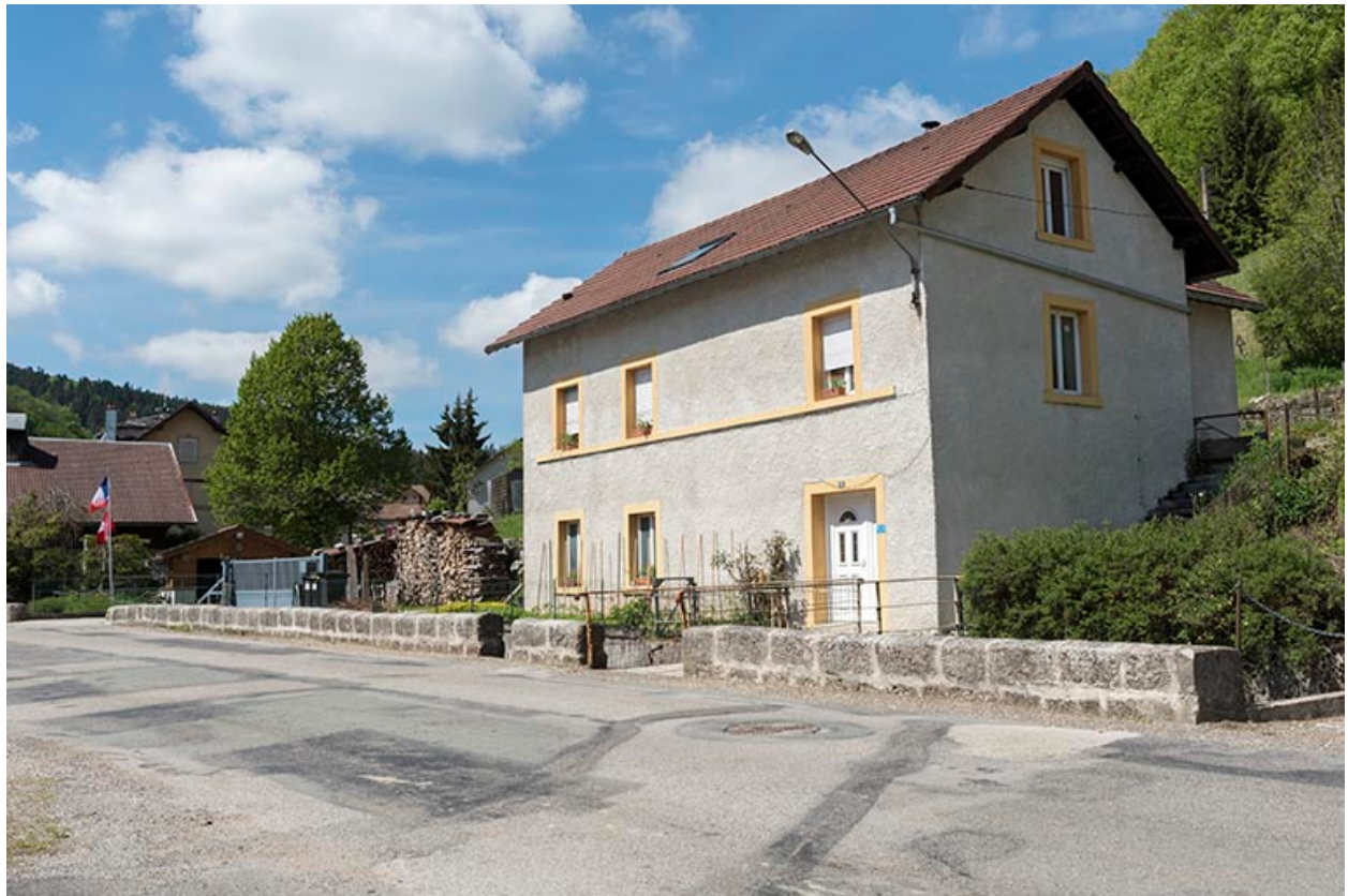
Façades antérieure et latérale droite.
