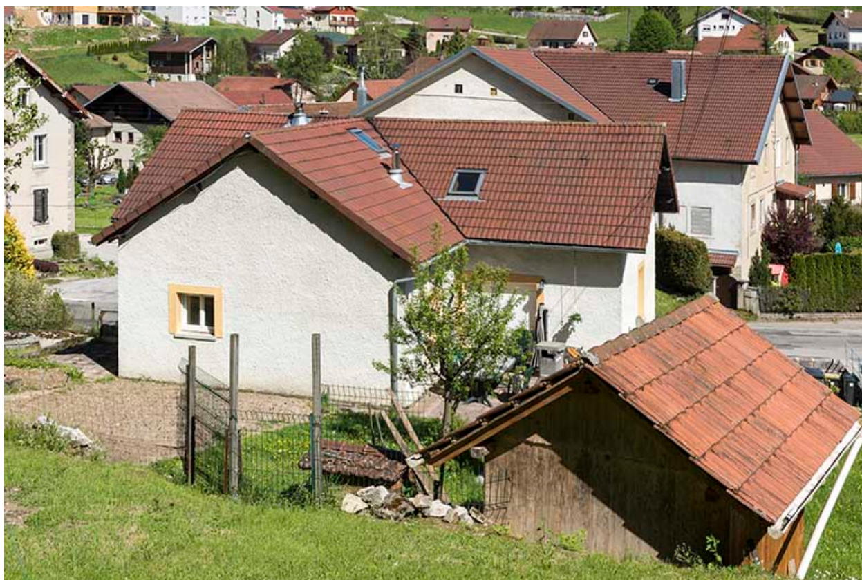
Façade postérieure (vue plongeante).
