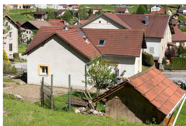
Façade postérieure (vue plongeante). Phot. Sonia Dourlot IVR43_20172500539NUC4A
