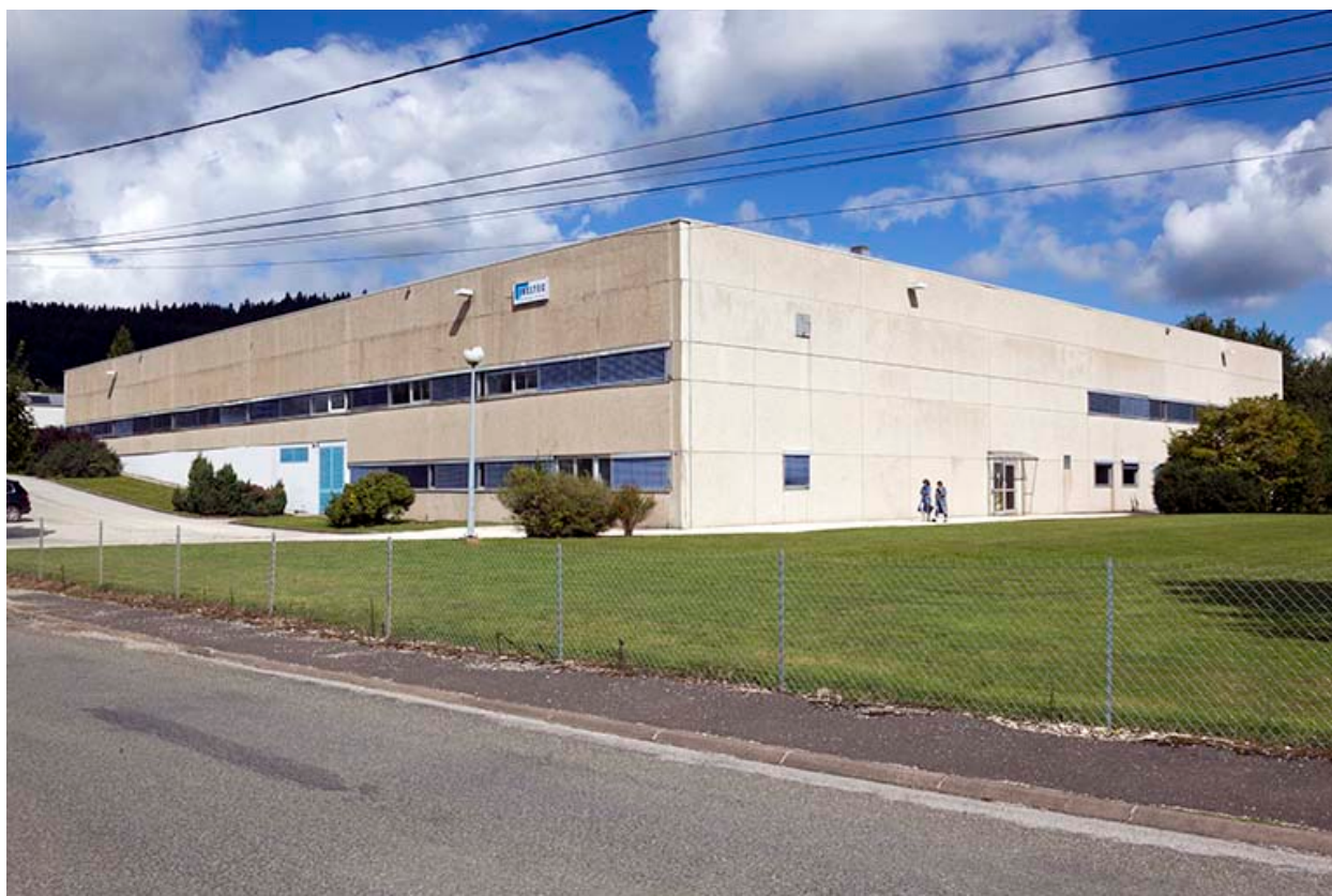
Vue d'ensemble, depuis le sud.
