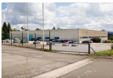
Vue d'ensemble, depuis l'ouest.
