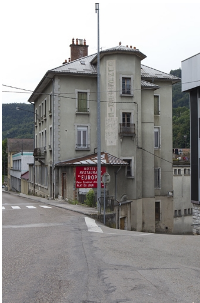
Façades antérieure et latérale droite.
