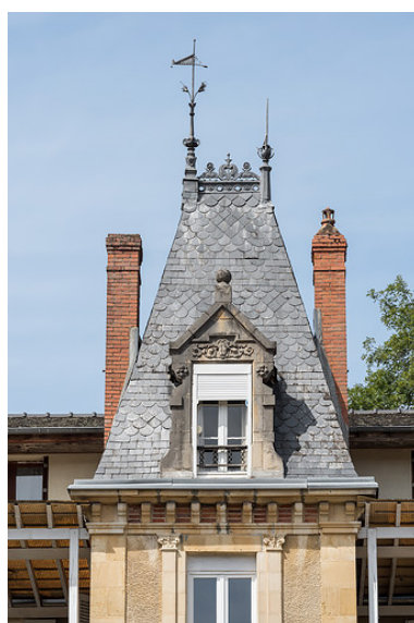
Toit à quatre pans en ardoise de la tour avec crête et épi de faîtage. Phot. Pierre-Marie Barbe-Richaud IVR26_20195800677NUC4A
