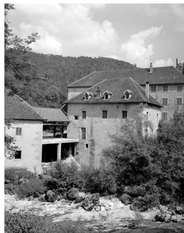
Moulin : façade latérale gauche. Phot. Yves Sancey IVR43_19923900850X
