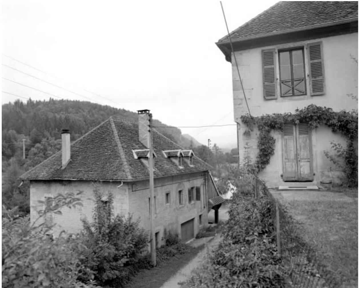
Moulin : façades antérieure et latérale droite.
