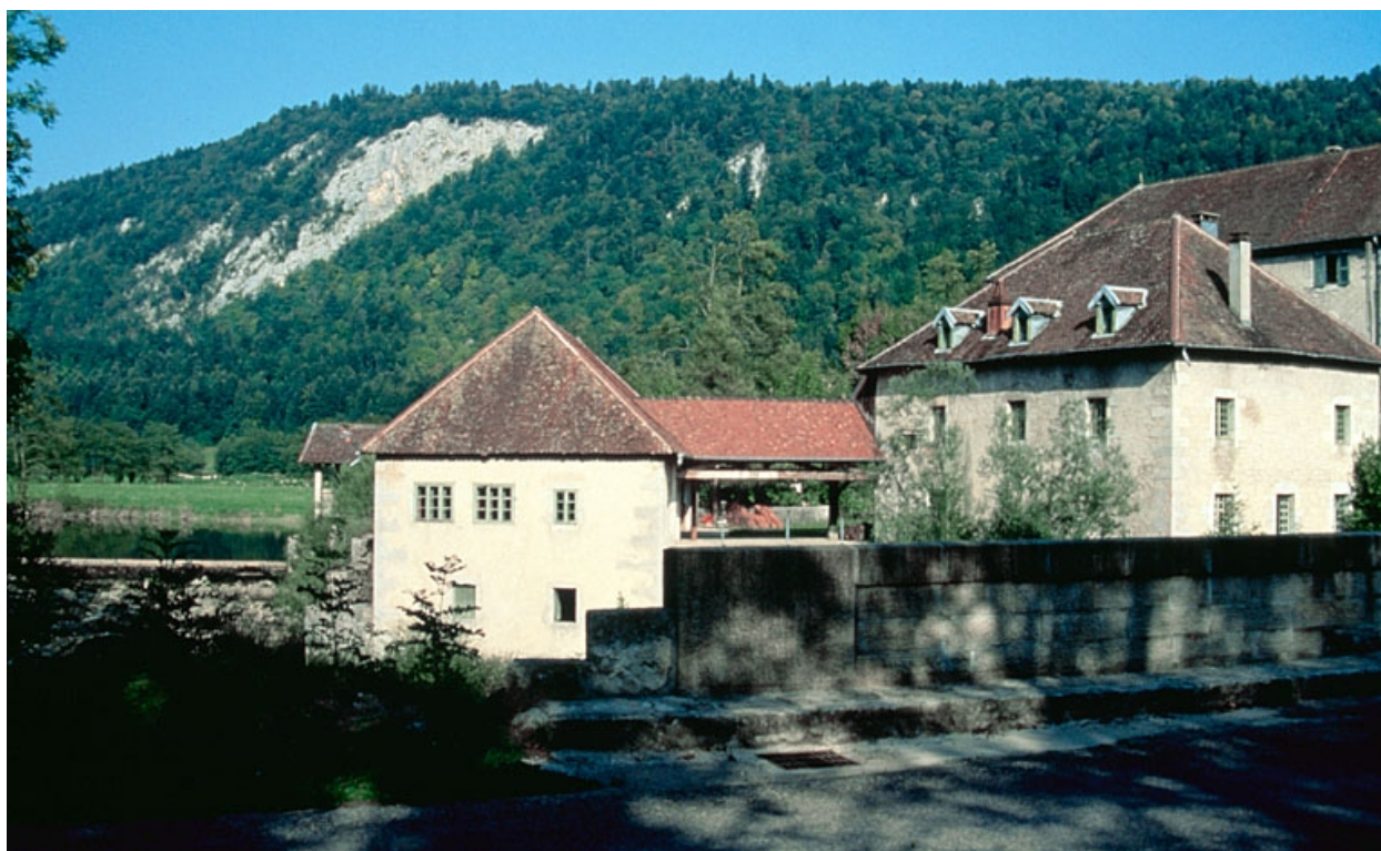
Vue d'ensemble depuis le pont, à l'ouest.
