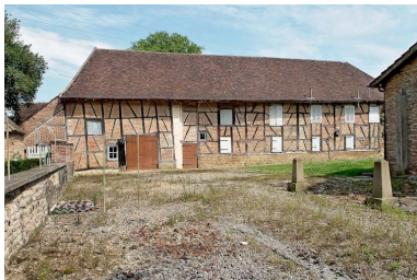
Château de Lusigny : ferme de face. Phot. Jean-Luc Duthu IVR26_20107100470NUC2A
