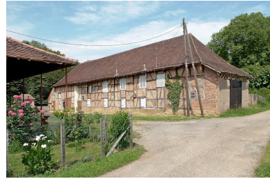
Château de Lusigny : ferme de face. Phot. Jean-Luc Duthu IVR26_20107100471NUC2A
