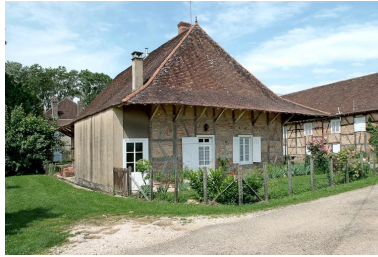
Château de Lusigny : ferme. Phot. Jean-Luc Duthu IVR26_20107100469NUC2A
