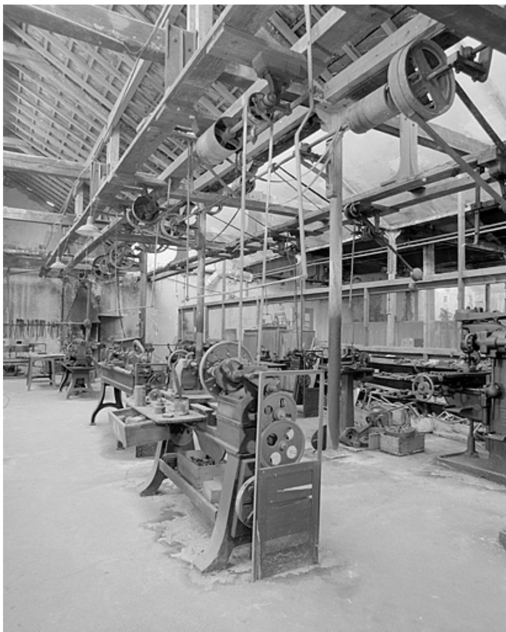
Atelier de mécanique. Distribution par courroies verticales.
