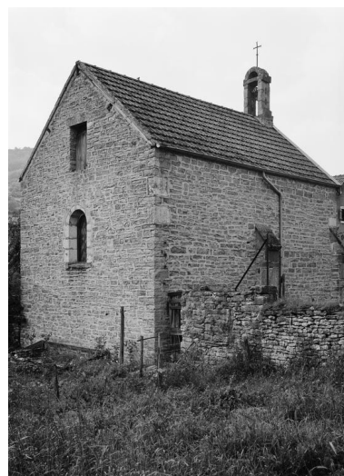
Vue du chevet du mur gauche. Phot. Michel Rosso IVR26_19792100050V
