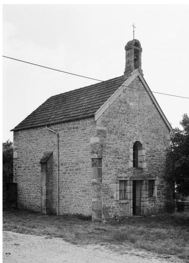
Vue de la façade et du mur gauche. Phot. Michel Rosso IVR26_19792100049V
