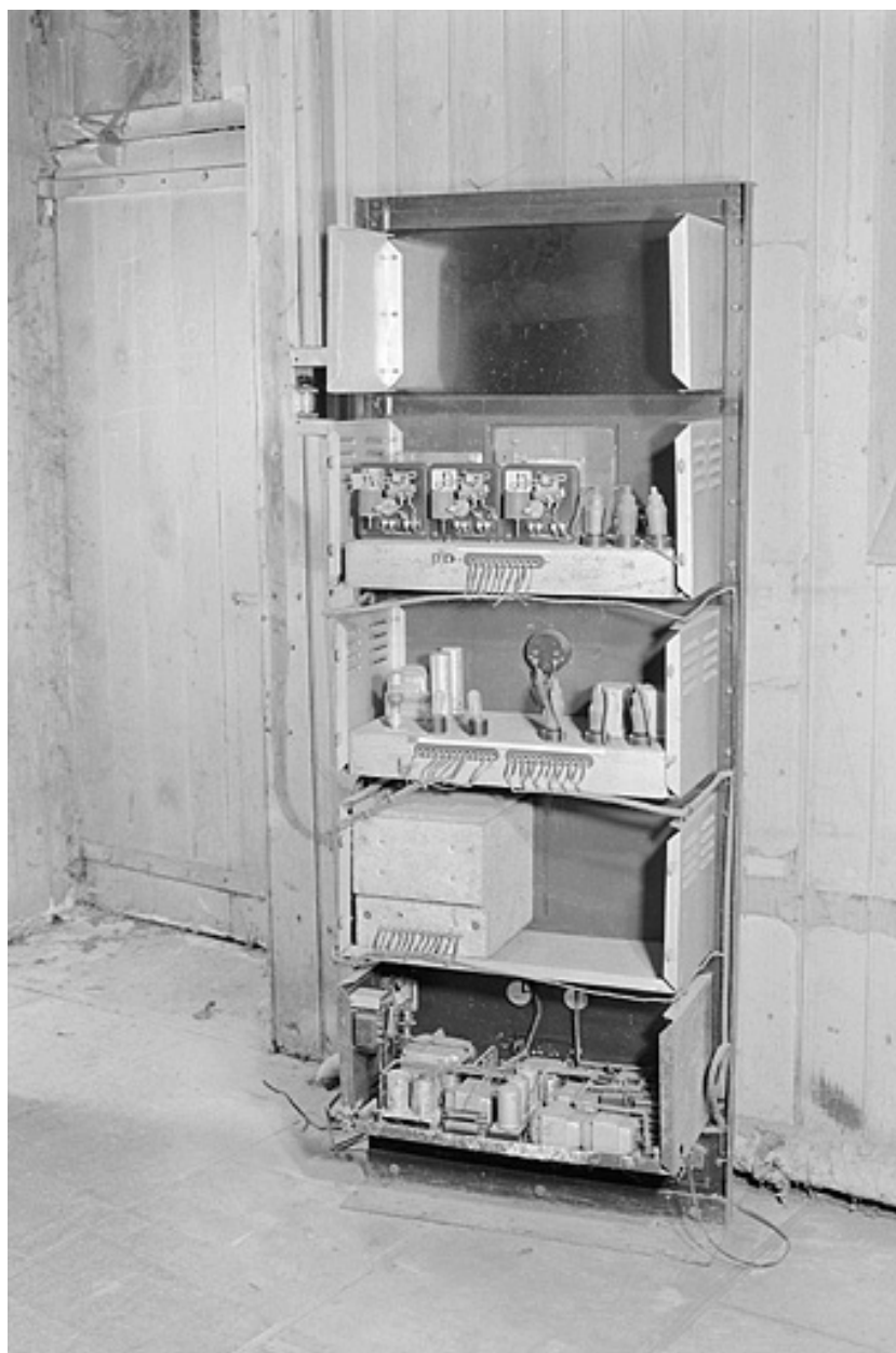
Diapason étalon : face arrière.
