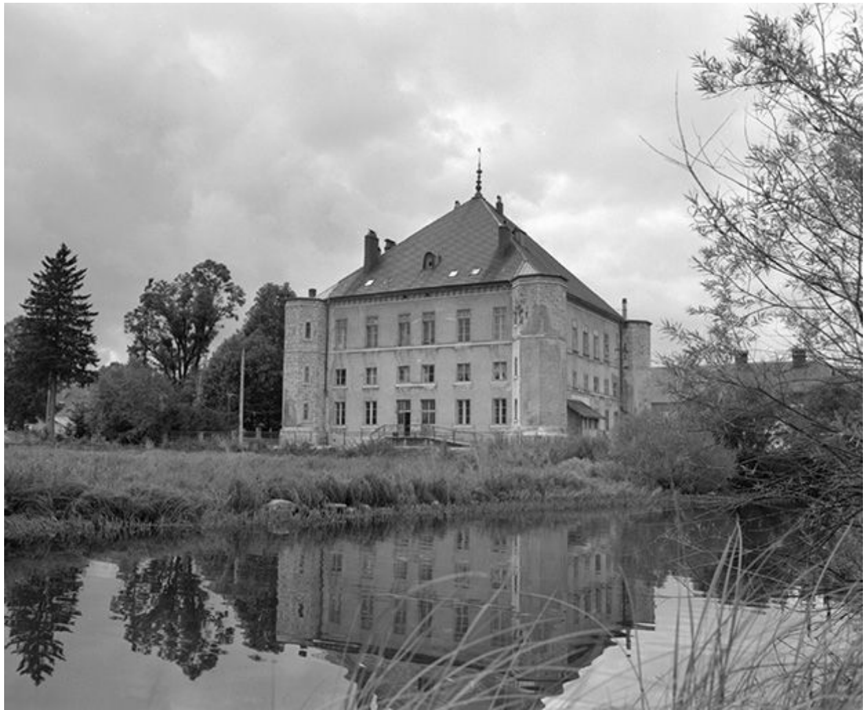
Façade postérieure et latérale gauche.
