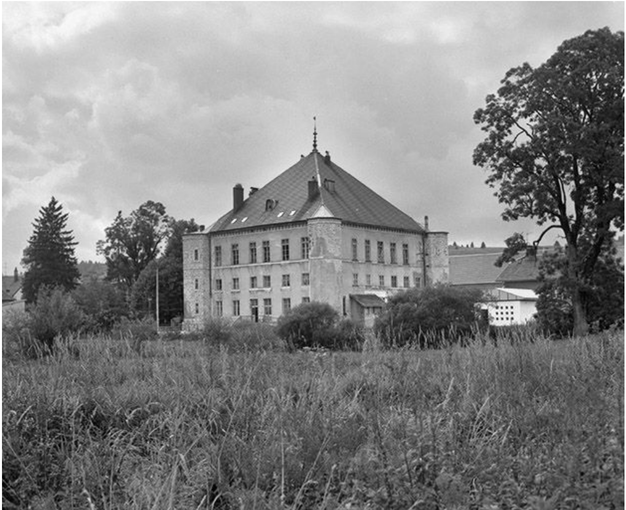
Façade postérieure et latérale gauche.
