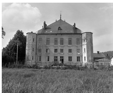
Façade postérieure. Phot. Yves Sancey IVR43_19782500448X
