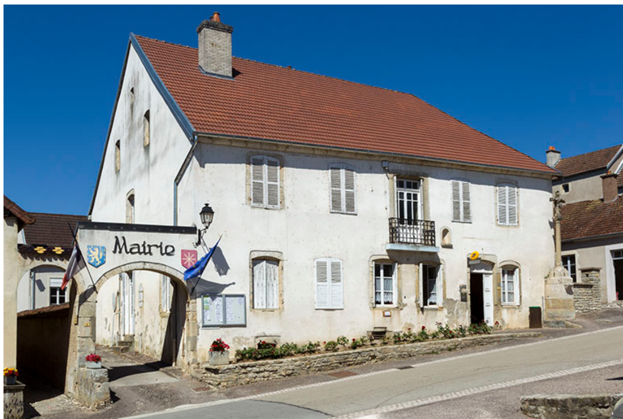
Mairie-école primaire de garçons, 2-4 Grande-Rue.
