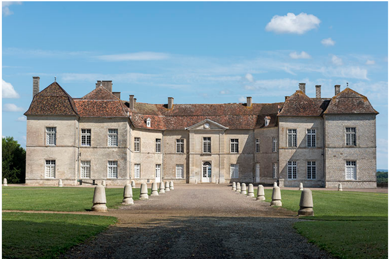
Le château, façade sur la cour d'honneur.
