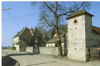
Vue d'ensemble depuis la rue.
