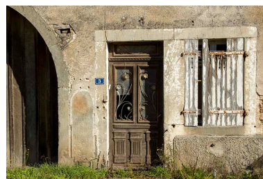
L'entrée de la partie habitation. Phot. Sonia Dourlot IVR43_20157000609NUC2A
