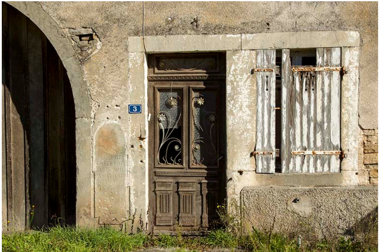
L'entrée de la partie habitation.
