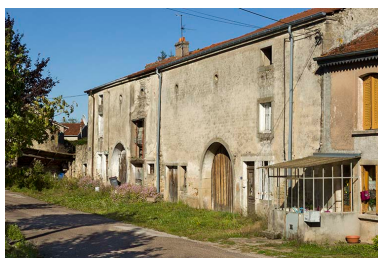
Façade antérieure. Phot. Sonia Dourlot IVR43_20157000608NUC2A
