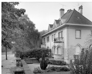
Façade antérieure, vue de trois quarts. Phot. Yves Sancey IVR43_19893900455X
