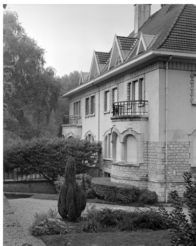
Façade antérieure, vue de trois quarts. Phot. Yves Sancey IVR43_19893900458X
