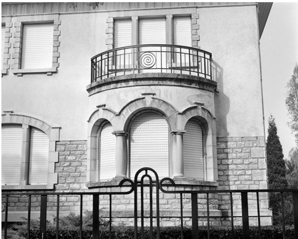
Détail : la logette du 16 avenue Albert 1er.
