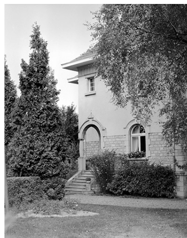
Détail de la face gauche. Phot. Yves Sancey IVR43_19893900460X
