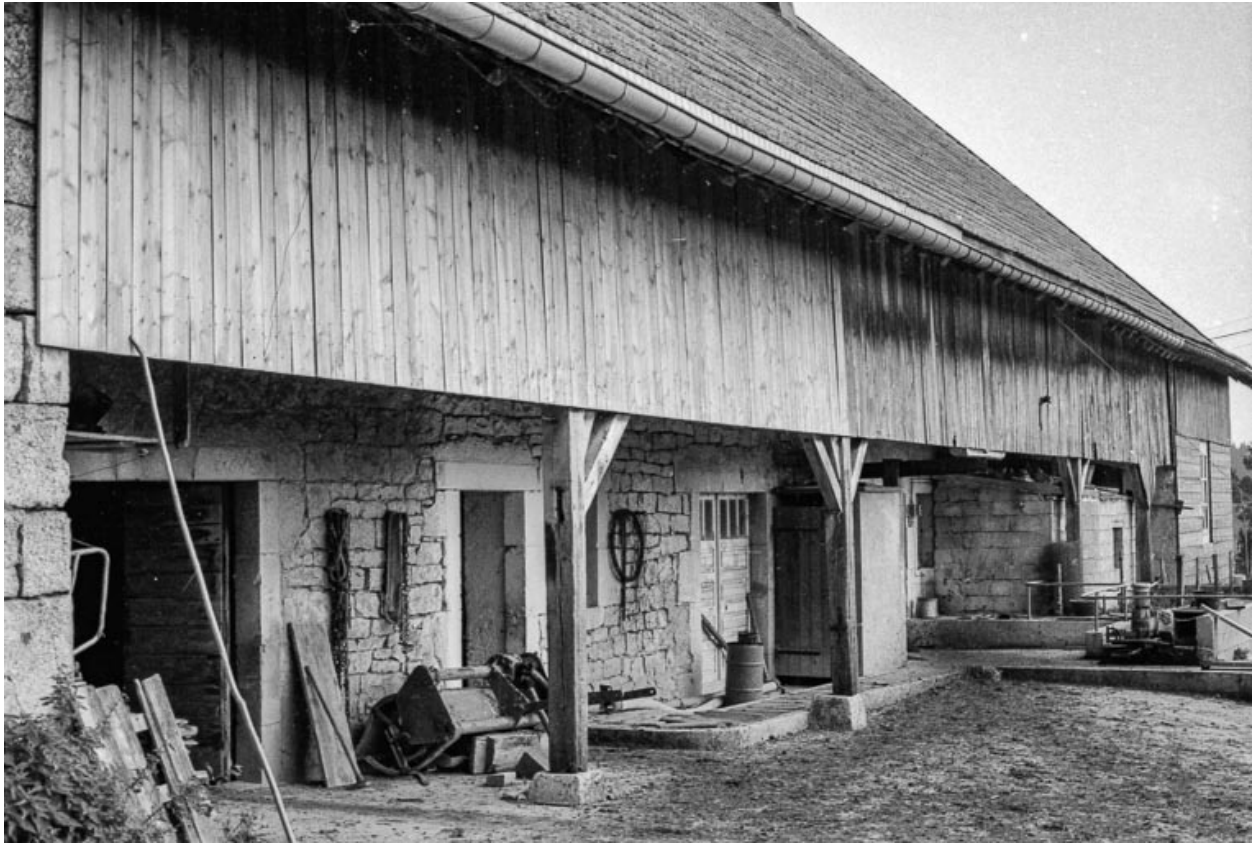
Mur gouttereau gauche.
