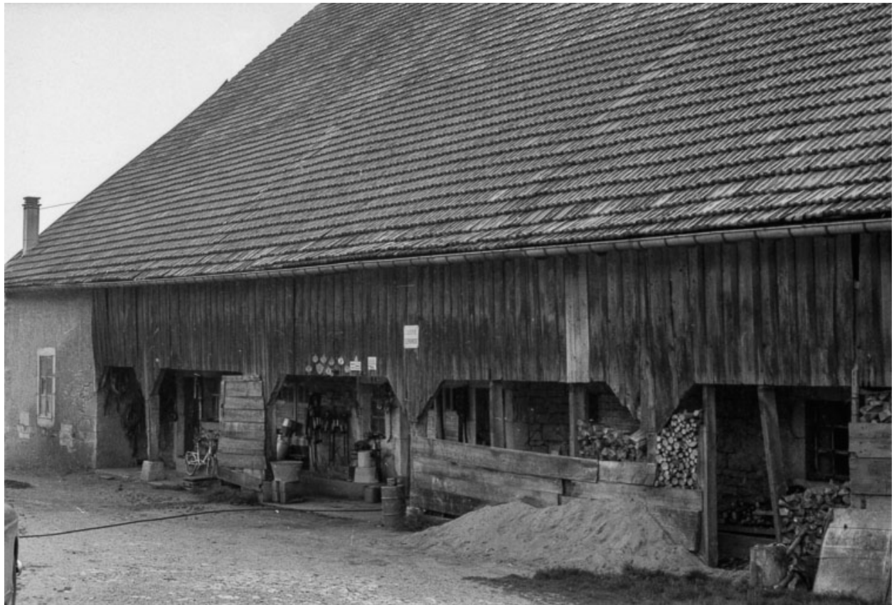
Mur gouttereau droit.
