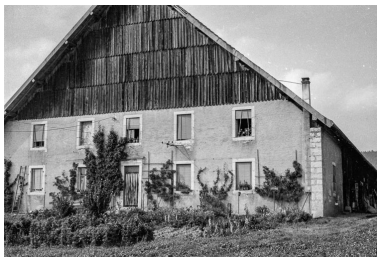
Façade antérieure. Phot. Gilbert Poinso IVR43_19752501318Z
