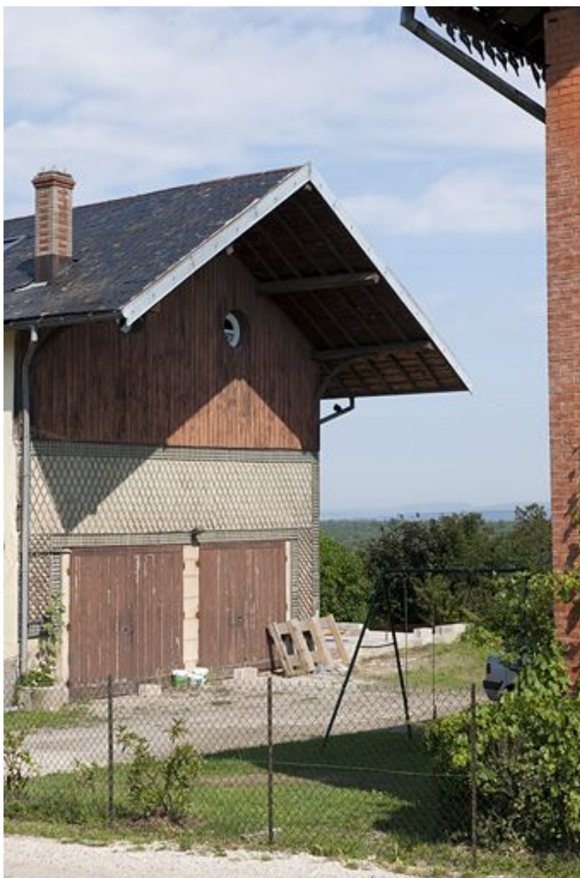
Pignon du bâtiment des remises.
