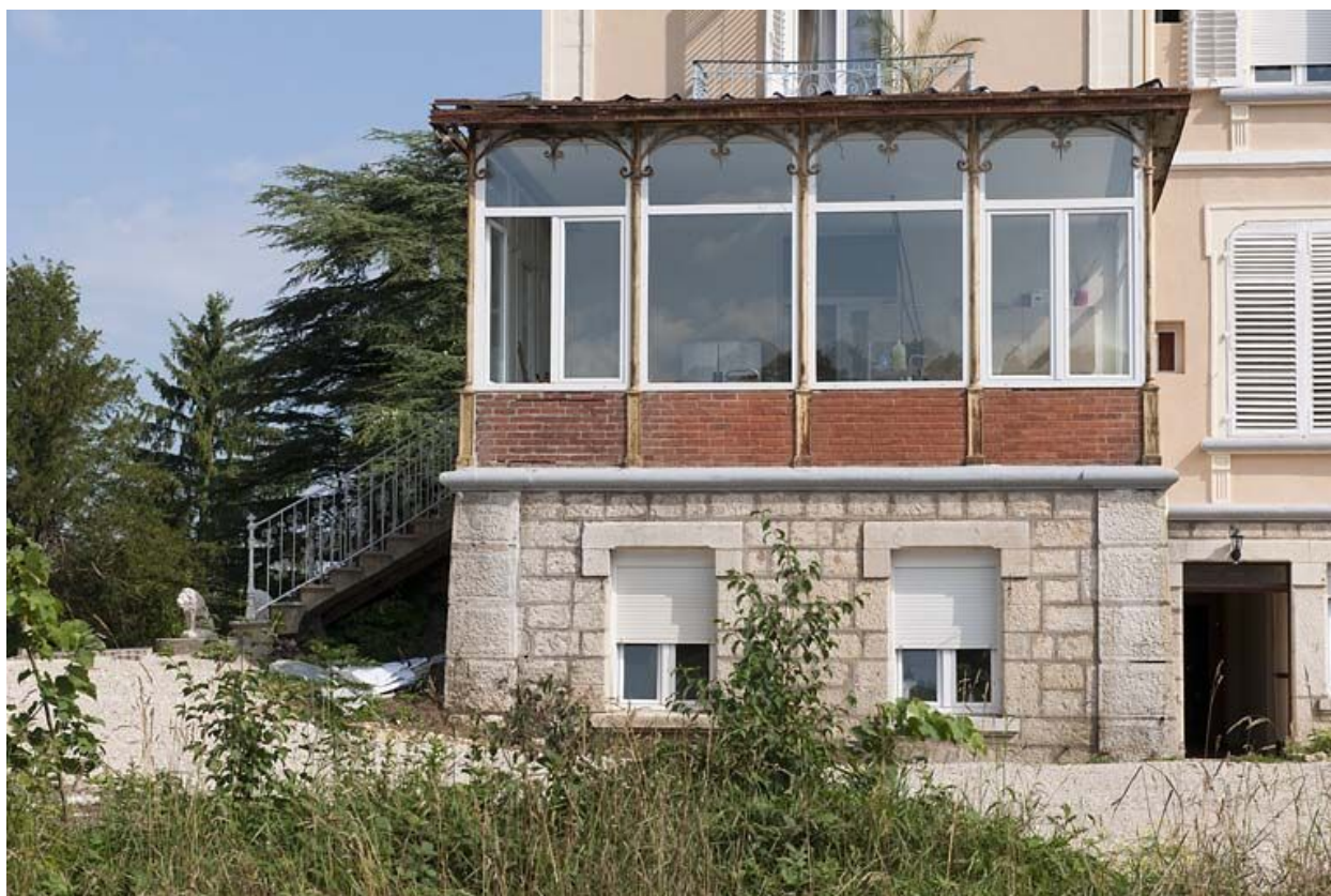
Détail de la véranda.
