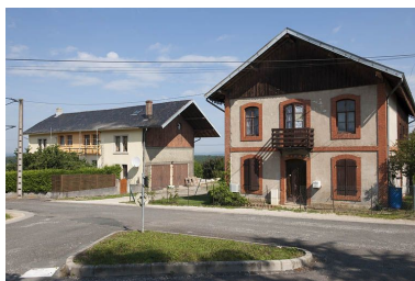
Les communs : écurie, remise et logements. Phot. Jérôme Mongreville IVR43_20112501220NUC4A
