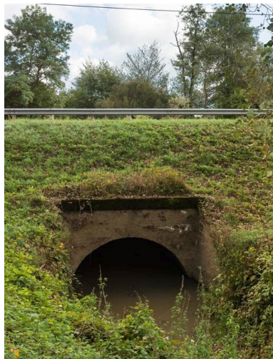
Vue de l'aqueduc.
