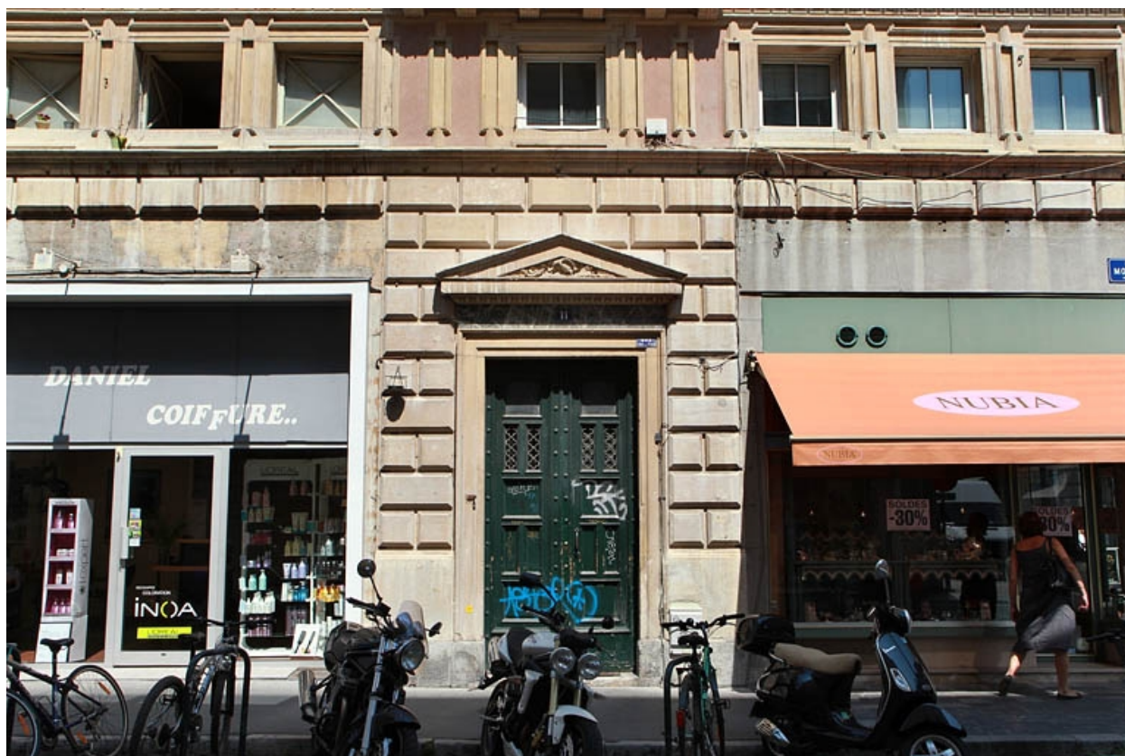
Façade antérieure : détail du rez-de-chaussée, de face.
