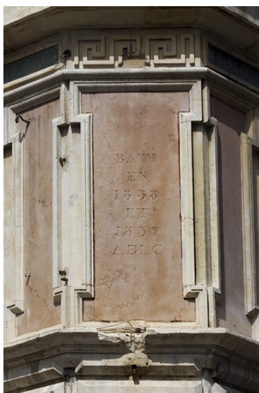
Angle du bâtiment : détail de l'inscription.
