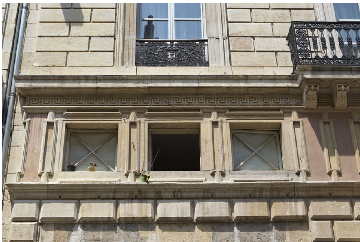
Façade antérieure : détail de l'entresol.
