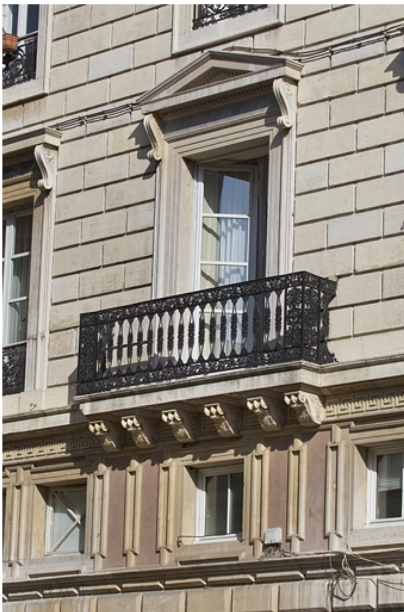
Façade latérale droite : détail du balcon.
